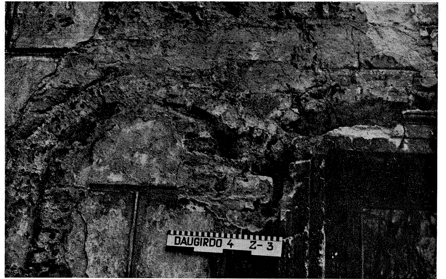
2 pav. Siaurinio namo pagrindinio fasado pirmojo aukšto zondažas: langų nišos su dvigubomis segmentinėmis sąramomis, suremtomis į konsolinę plytą-spyną
