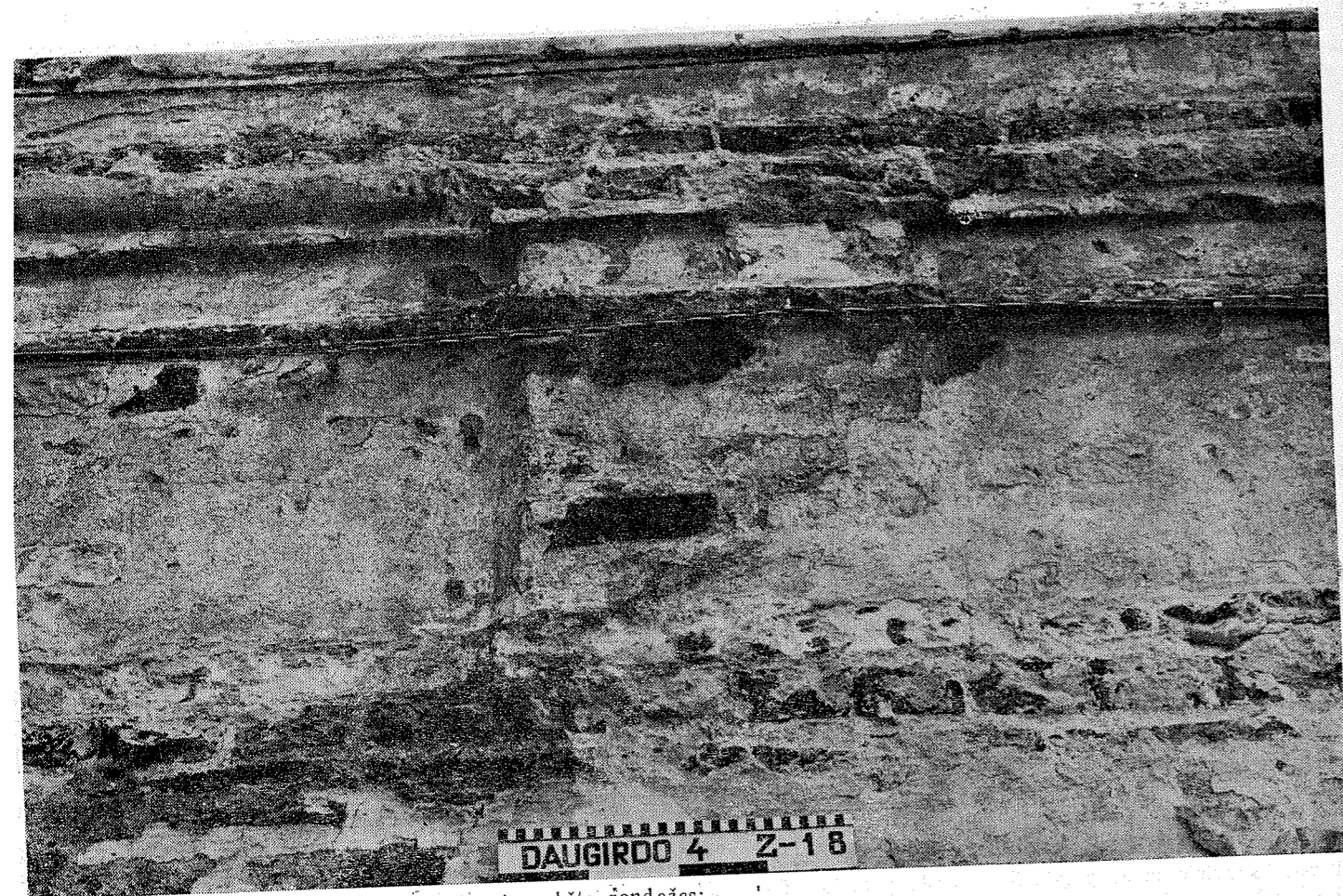
3 pav. Pietinio namo pagrindinio fasado pirmojo aukšto žondužas: 1770 metais suformuota tarpaukštinė frizinė juosta, kurios profiliui naudotos plonos plytelės
