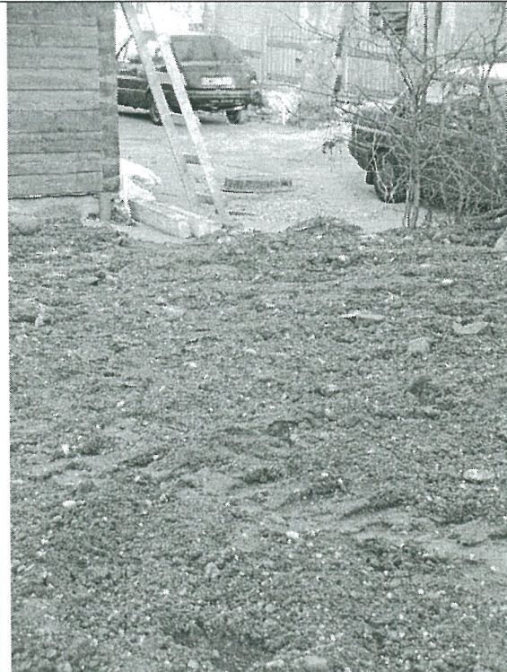
Foto 8. Tiriamas sklypas po tranšėjos užkasimo. Vaizdas iš R pusės.
