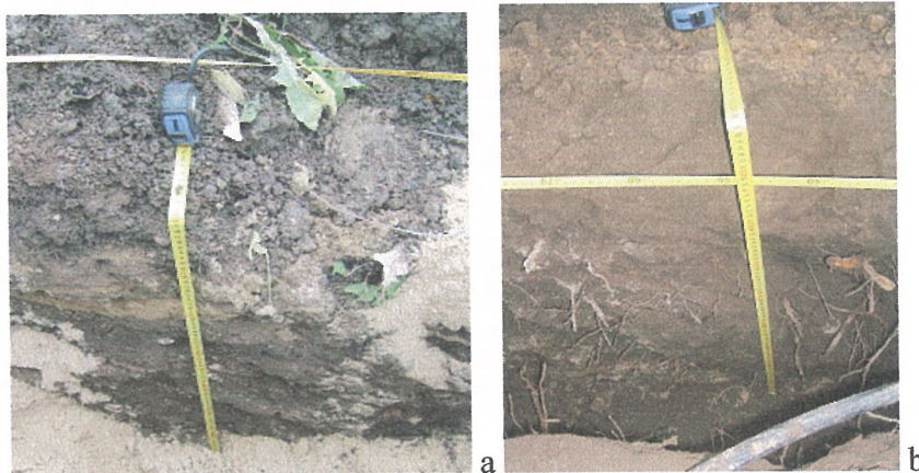
106 pav. Antrosios elektros kabelio tranšėjos R-ŠR siena: a- 6 m; b-18 m
