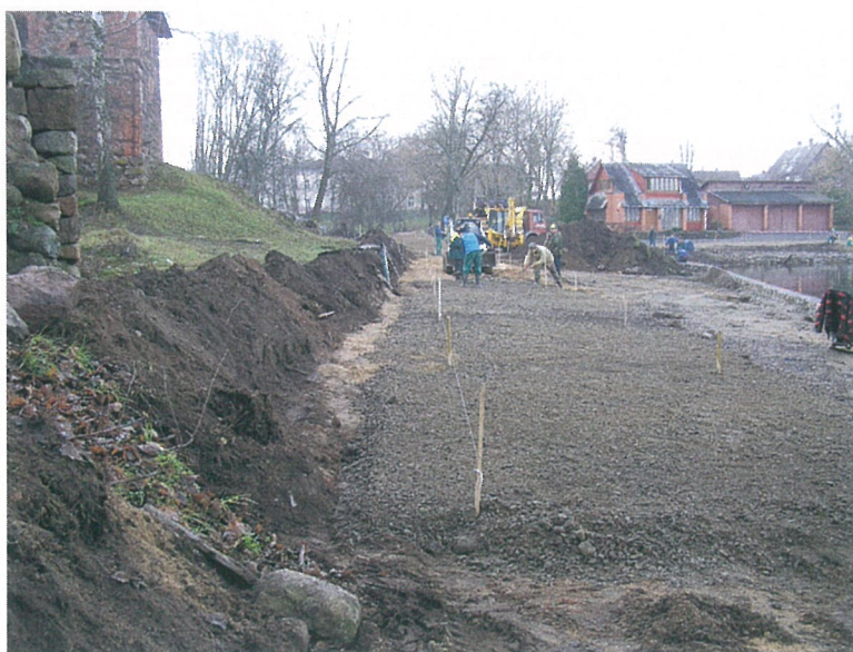
6 pav. Archeologinių žvalgymų pabaiga – pilami smėlio ir skaldos sluoksniai
