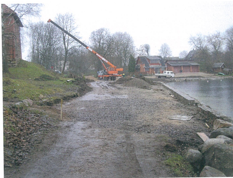
3 pav. Statybos darbų vieta prieš pradedant žvalgymus
