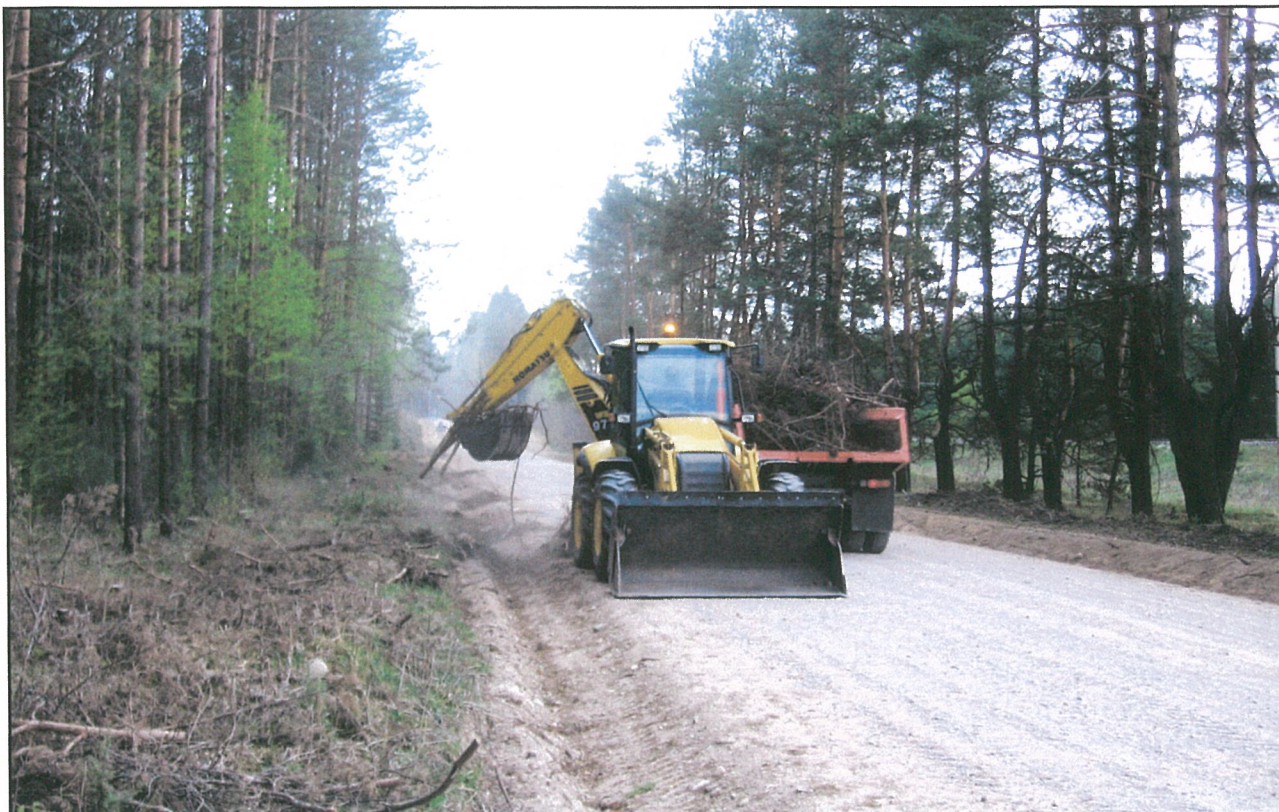
Pav. 14. Kelio darbai Liūlinės III pilkapyne [A1085P]. Rytinė kelio pusė (ruožas į šiaurę nuo ištirto pilkapiro). Pakelės šakų, kelmų ir šiukšlių surinkimas. Fotografuota iš ŠR pusės.
