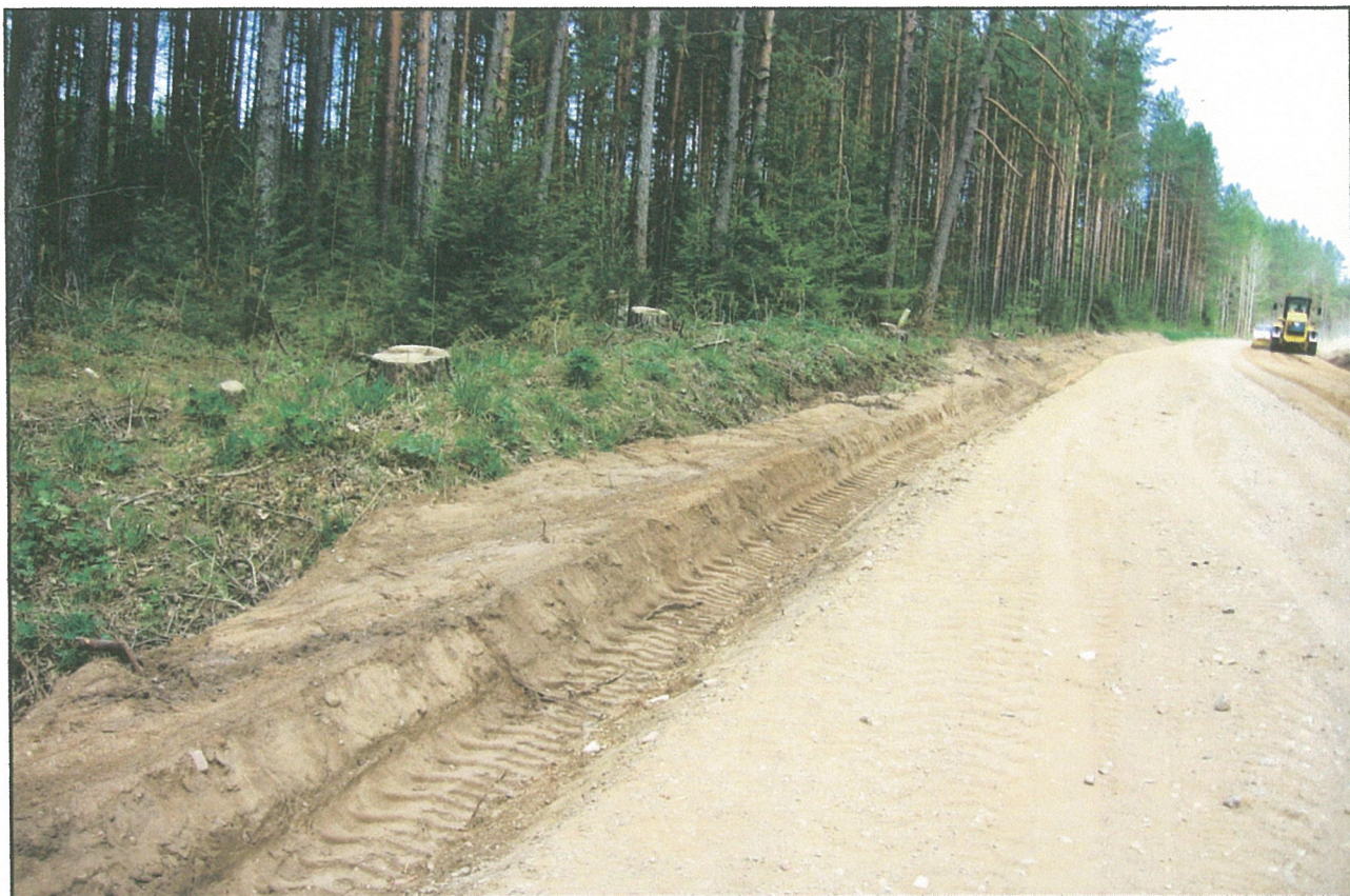
Pav. 4. Kelio darbai Paduobės-Šaltaliūnės II pilkapyne [A1095P]. Vakarinė kelio pusė (ruožas į šiaurę nuo žvyrkelį kertančio miško keliuko). Fotografuota iš P pusės.
