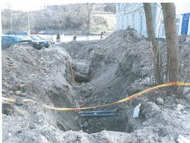
5. Tranšėjos ŠV dalis (A atkarpa) iš PV pusės
