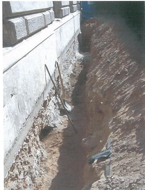
10. PR gatvės tranšėja
