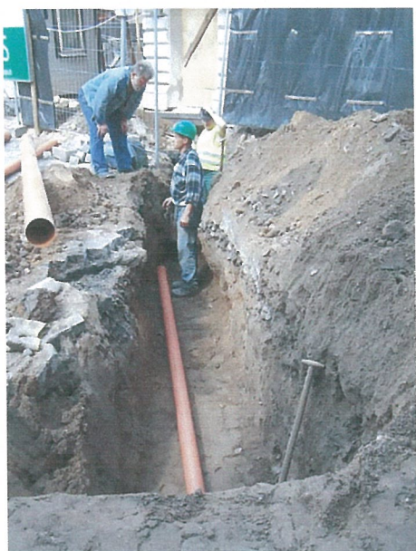
15. P gatvės tranšėja iš R pusės
