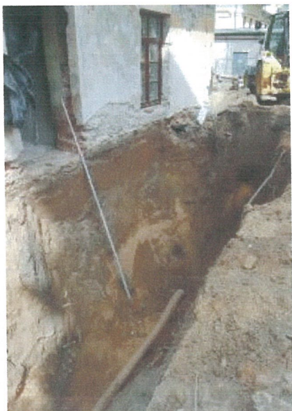
39. R pastato fasadas. Tranšējos Nr. 3 vaizdas iš PR pusēs
