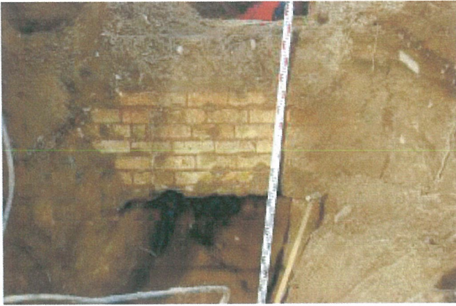
5. Tranšēja Nr. 1. Kolektorius Nr. 1 vaizdas iš R pusės
