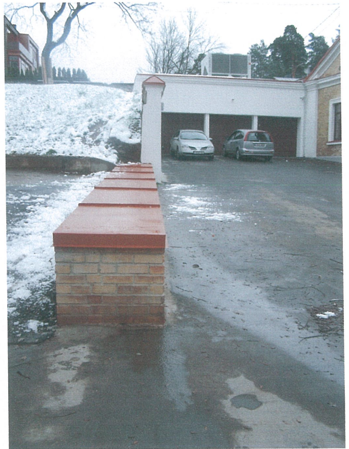
84. Atstatytos mūro Nr. 2 liekanos. Vaizdas iš V pusės
