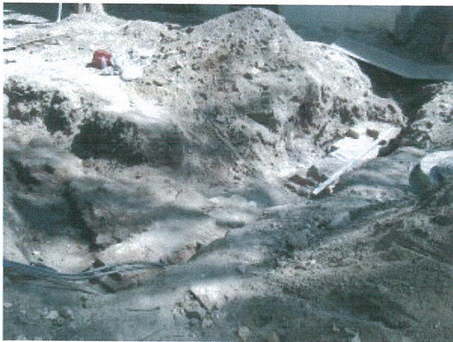
27. P mūro Nr. 1 dalis. Vaizdas iš PV pusės
