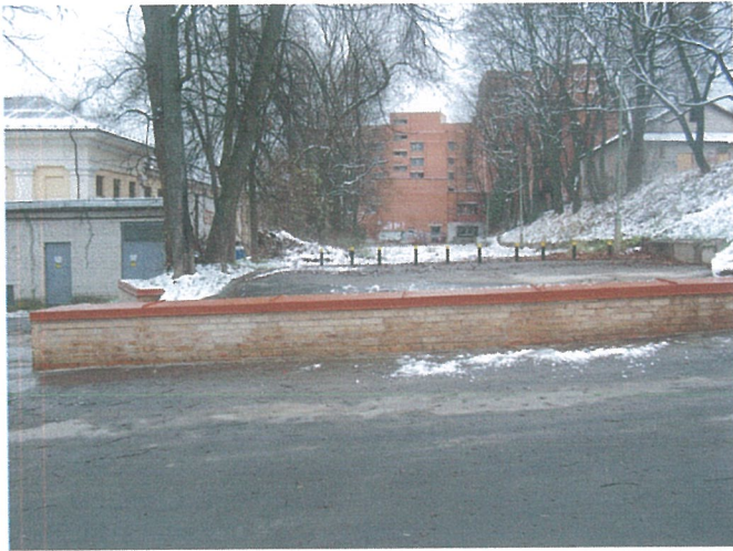
83. Atstatytos mūro Nr. 2 liekanos. Vaizdas iš P pusės
