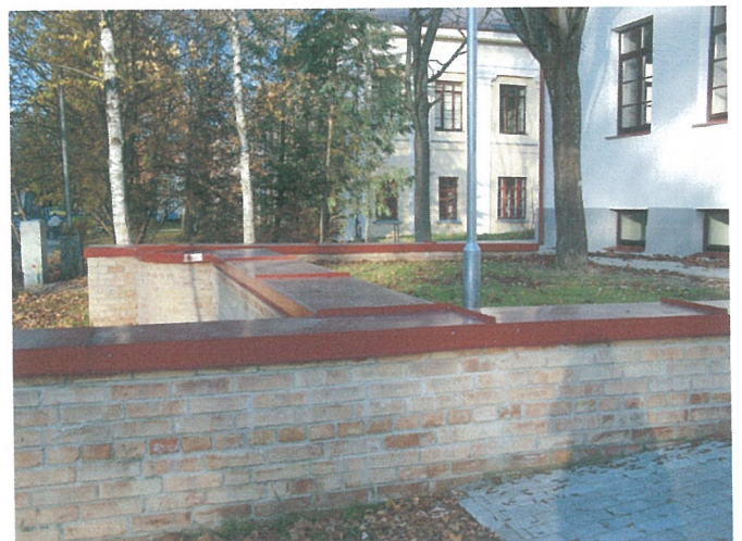
82. Atstatytos mūro Nr. 1 liekanos. Vaizdas iš P pusės
