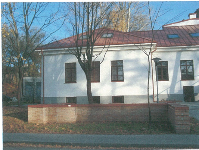
81. Atstatytos mūro Nr. 1 liekanos. Vaizdas iš V pusės
