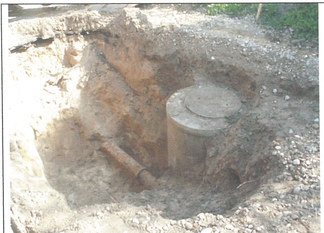
31. Komunikacijų tiesimas Krivių gatvėje. Bendras vaizdas iš Š pusės.
