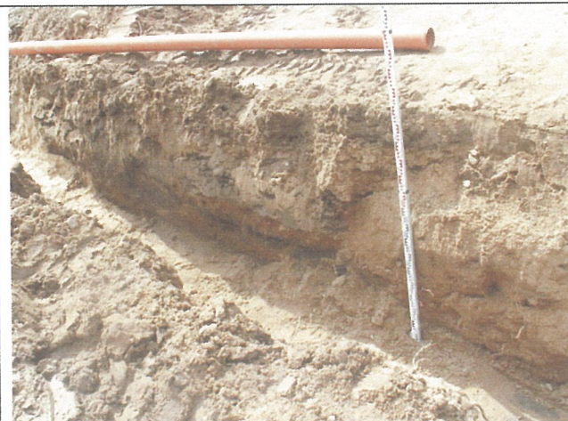
29. Komunikacijų tiesimas. Tranšėjos bendras vaizdas iš Š pusės.
