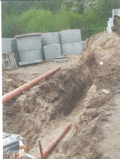
28. Komunikacijų tiesimas. Tranšėjos bendras vaizdas iš R pusės.
