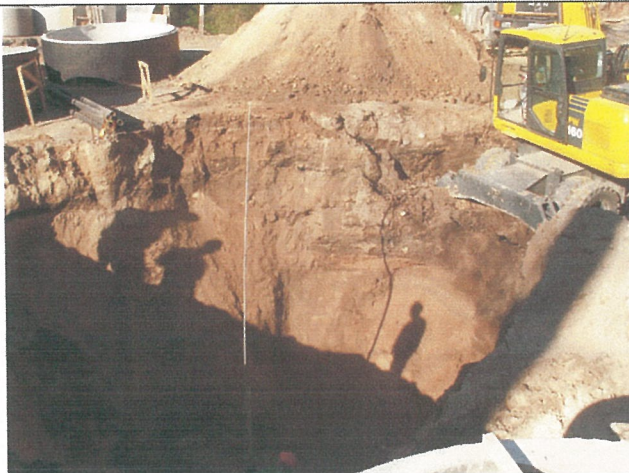
27. Komunikacijų tiesimas. Šulinio montavimo vieta. Centrinė sklypo dalis, vaizdas iš PR pusės.
