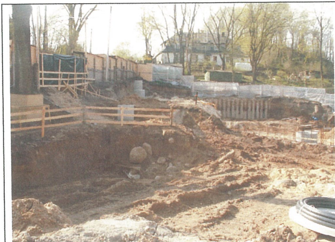
7. Bendras sklypo vaizdas iš R pusės. Pj. 1 – 1 bendras vaizdas.
