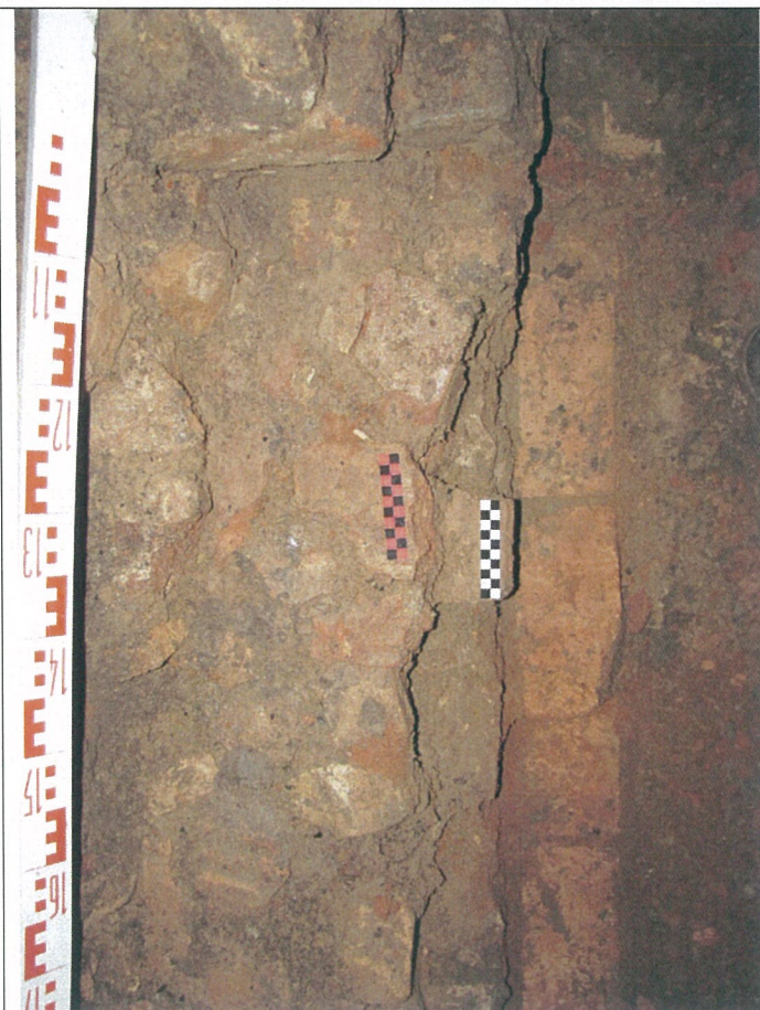
Fot. 7. Šurfe Nr. 1 atidengtas mūras.
