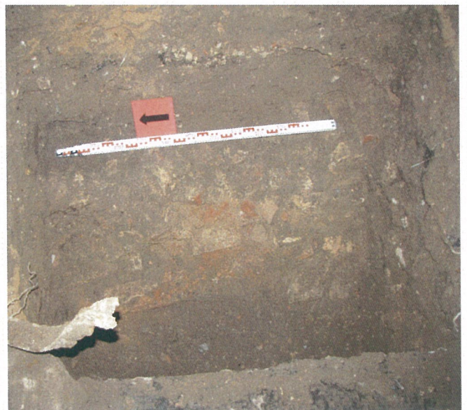
Fot. 8. Šurfe Nr. 1 atidengtas mūras.
