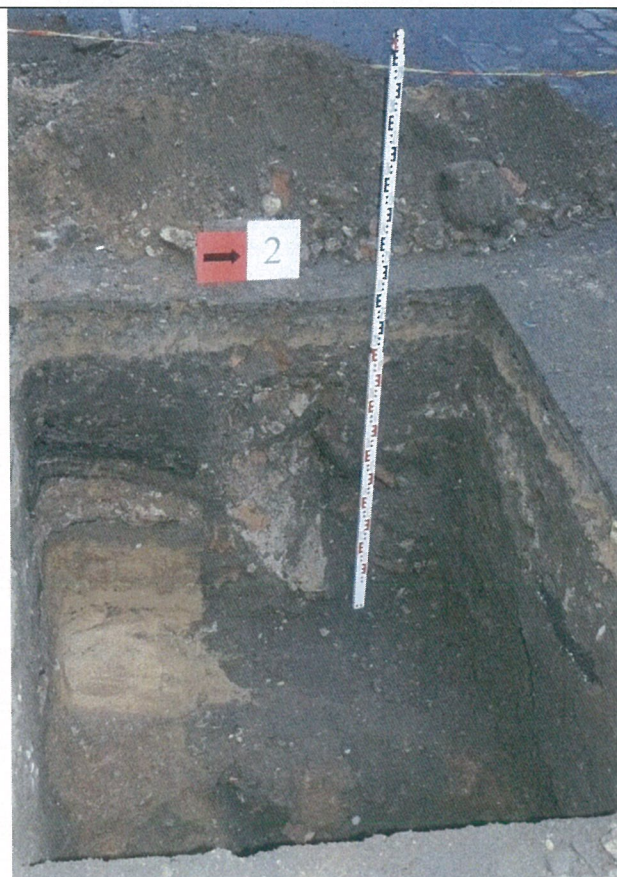
Fot. 12. Šurfas Nr. 2. Vakarinė sienelė.
