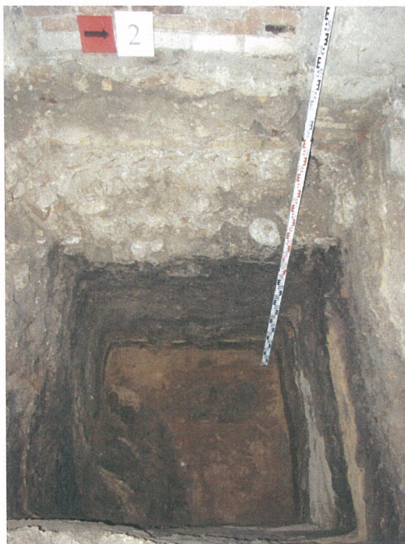
Fot. 18. Šurfas Nr. 2. Vakarinė sienelė.
