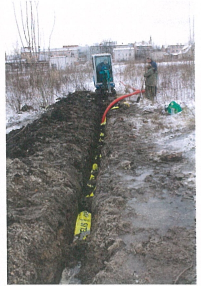
Foto-21. Atkarpa 1, tiesiamas kabelis
