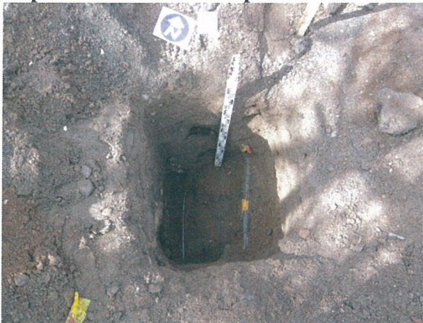
36 pav. šurfas nr.17 iš PR pusės
