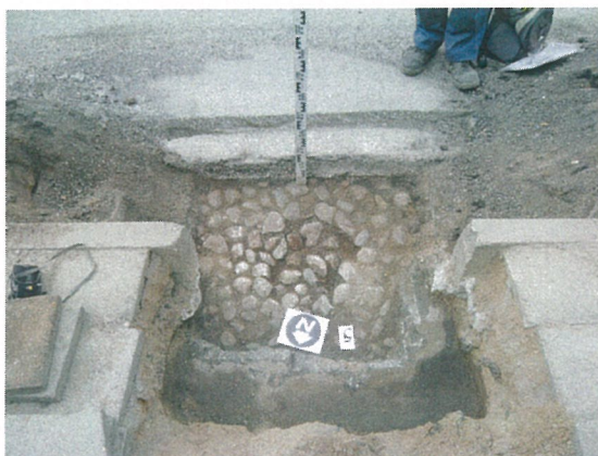
11 pav. šurfas nr.5 nuėmus asfaltą iš ŠV pusės
