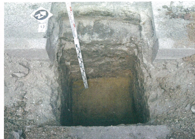
21 pav. šurfas nr.9 iš PR pusės
