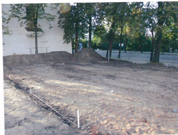
2. Perkamos Nr.1, 3, 2 nuėmus asfaltą. Vaizdas iš PR pusės.
