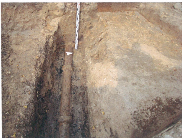
17. Perkasa Nr. 1. Atidengtas nuotekų vamzdis. Kv. A-B-C 8-9.
