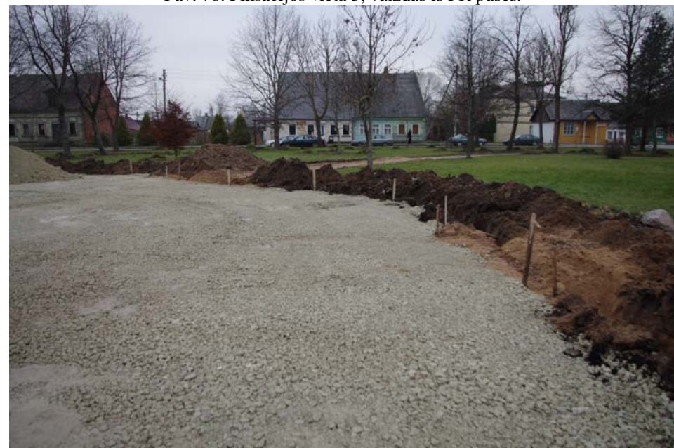
Pav. 77. Aikštės centrinė dalis iškasus tranšėjas.
