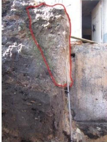
3. Betoninių pamatų vaizdas iš R pusės.
