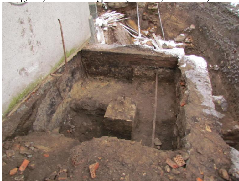
65. Atidenginėjami paviljono pamatai ir XX a. pr. pastato pamatų kolona, kv. B-D/1 1 -2.
