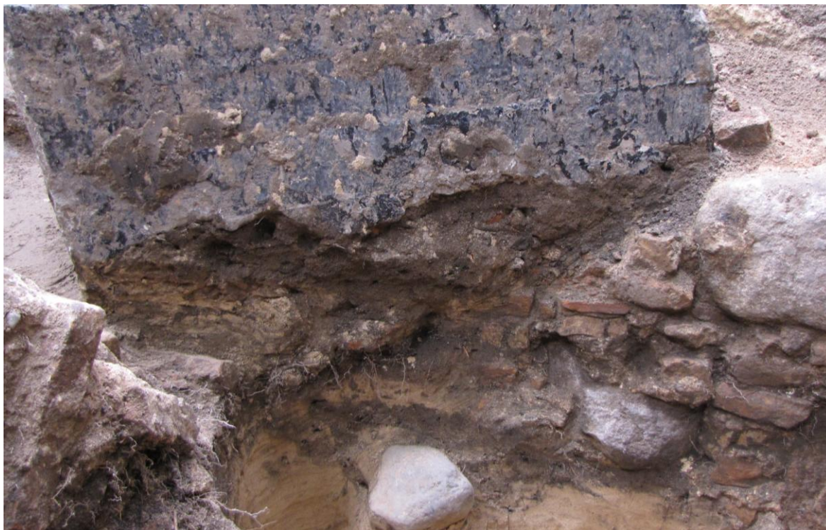
Fot. 35a. Piltinio pobūdžio gruntas, susiformavęs tarp XVII a. rūsių V ir Š sienų liekanų (M1) ir statybų metu ant jų užverstos betoninės konstrukcijos. Vaizdas nuo R.
