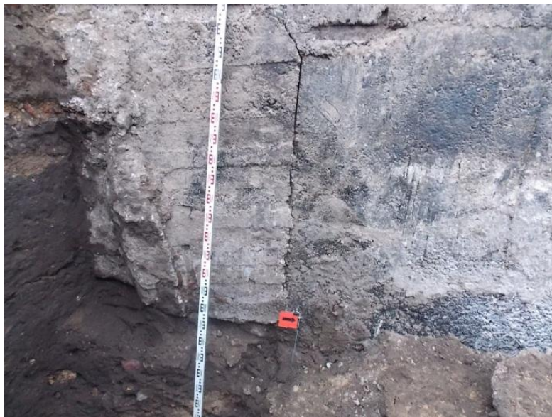
Fot. 86. XX a. statinio, Pylimo g. 7 A rytinės sienos pamatinė dalis P išpjoje, kv. 3 1 -1 1 / B, vaizdas nuo R
