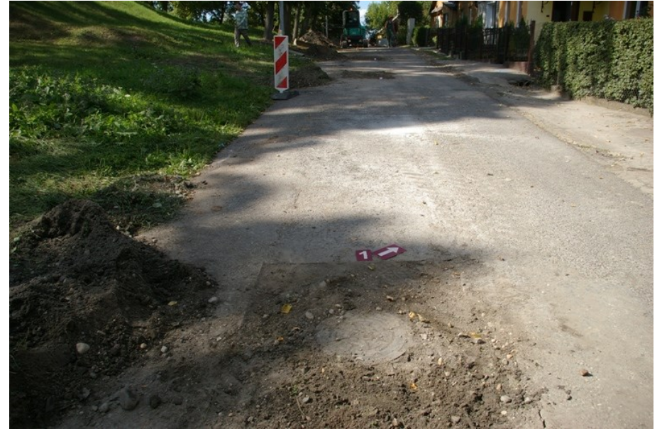
160. Fiksacijos vietos Nr. 1-4 po tyrimų – įrengti šuliniai, jos užpildos iš PR
