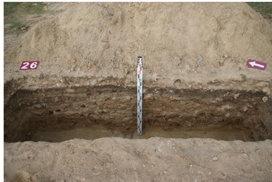
140. Šurfo Nr. 26 šiaurės rytinė sienelė iš V, PV
