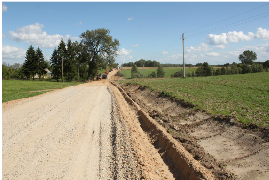
F.46. Nuimamas augalinis gruntas būsimų griovių vietose už saugomos teritorijos ribų, vaizdas iš V.
