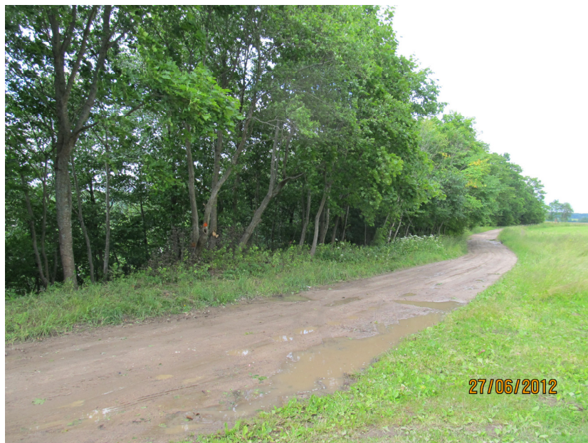
F.3. Kelio prasilenkimo (praplatėjimo) aikštelės vieta, vaizdas iš P.
