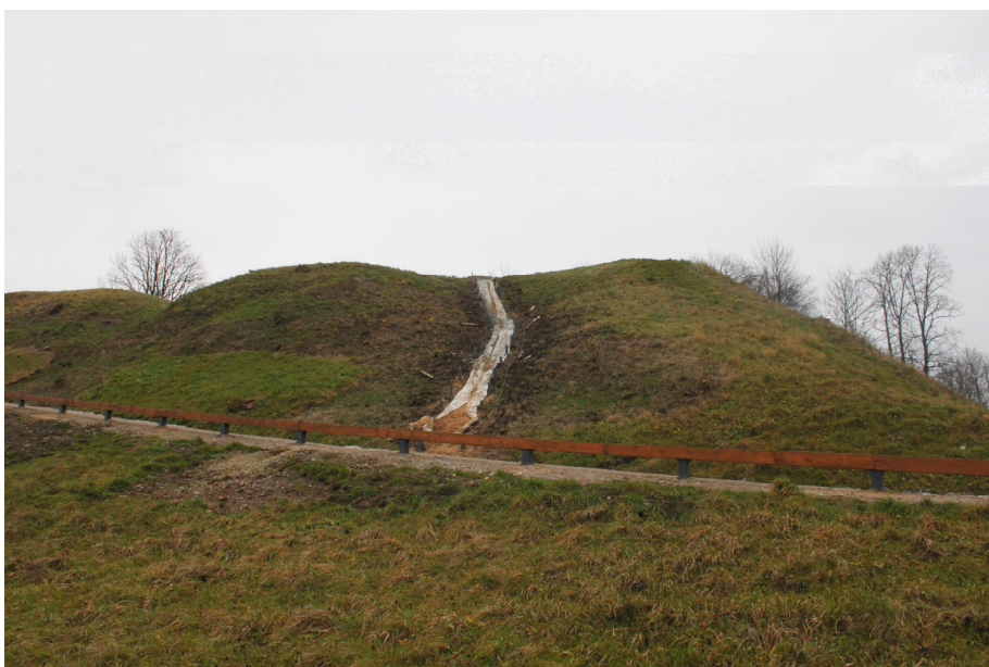
F 108. Po keliu įrengtos drenos šurfų Nr.1-2 vietose. Laiptų į V šlaitą vietoje nukasta velėna, įdėta geotekstilė ir užpilta drenuojančiu smėliu. Vaizdas iš V.
