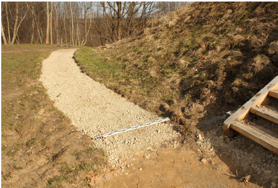
F 98. Takas, laiptai į pylimą šurfo Nr.13 vietoje. Vaizdas iš V.
