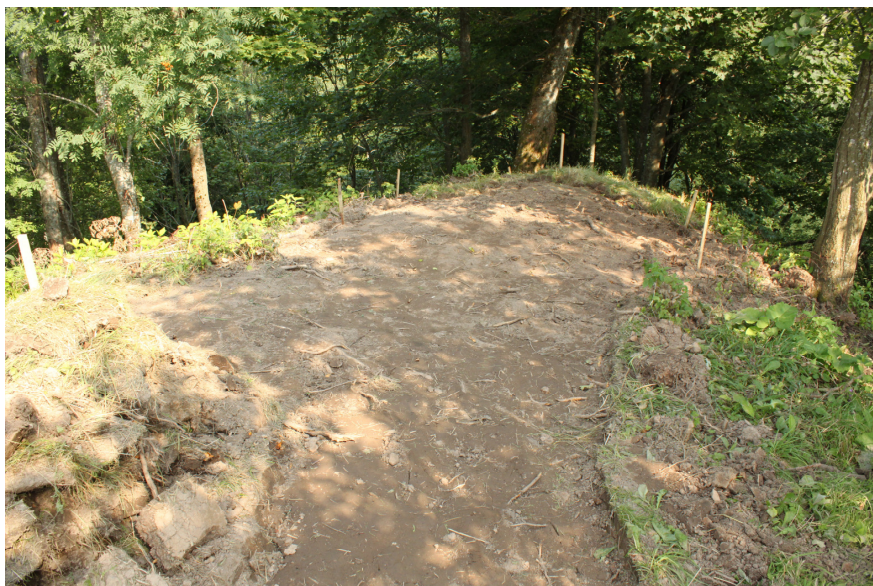
F 89. Užpiltas ir sutankintas gruntas plote Nr.8, ištirta tako ir apžvalgos aikštelės dalis PR piliakalnio dalyje, vaizdas iš V.
