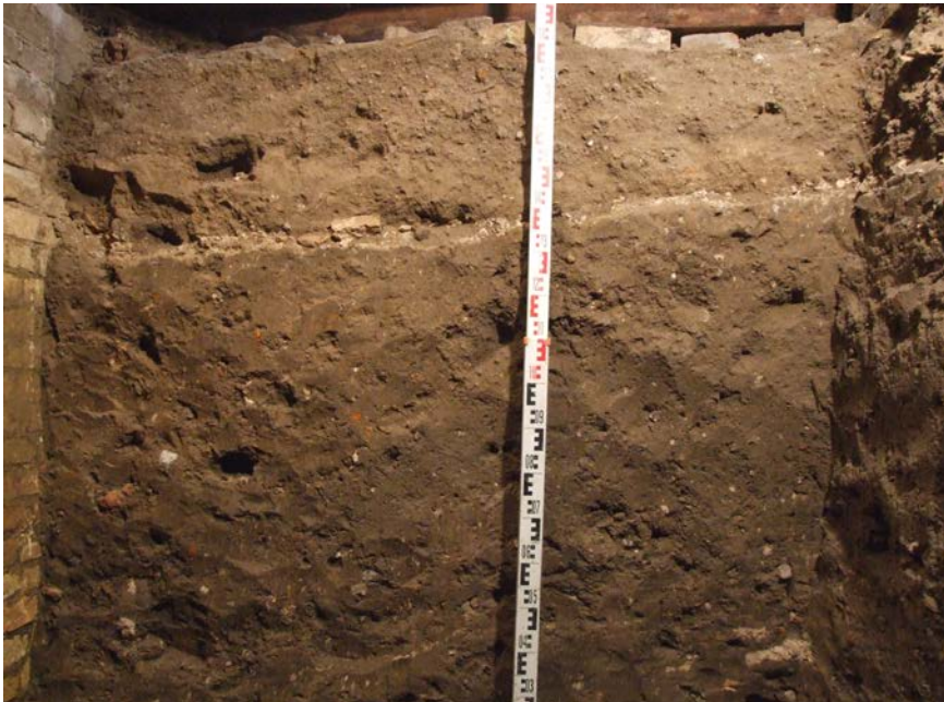
11 nuotr. Šūrfas Nr. 2. ŠR sienelės viršutinė dalis iš PV pusės
