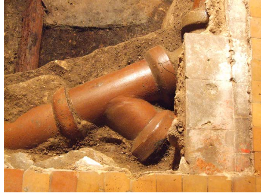
30 nuotr. Šurfas Nr. 4. Grindų plytelės ir kanalizacijos vamzdžiai iš PR
