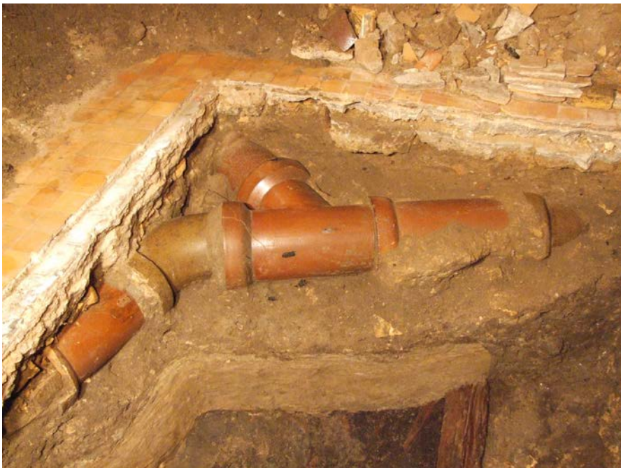
31 nuotr. Šurfas Nr. 4. Kanalizacijos vamzdžiai iš ŠV pusės
