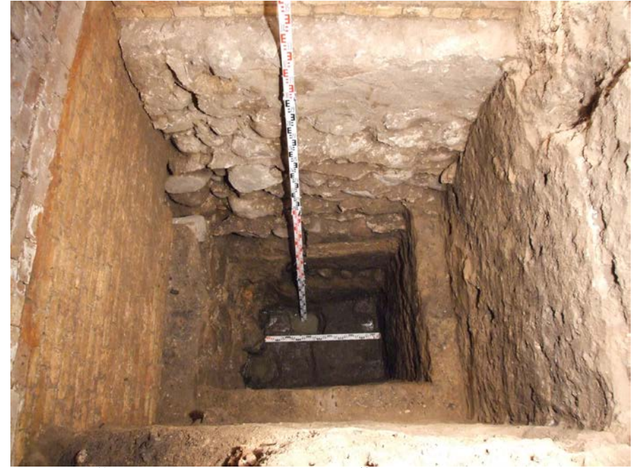
22 nuotr. Šurfas Nr. 3. Iširtas šurfas ir ŠR sienelė iš PV pusės
