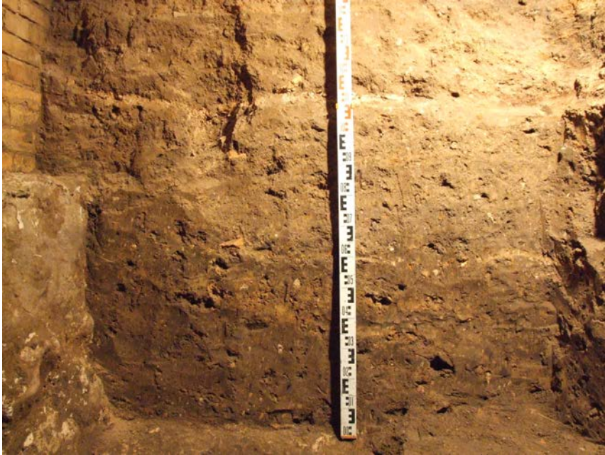
29 nuotr. Šurfas Nr. 3. PR sienelės viršutinė dalis iš ŠV pusės
