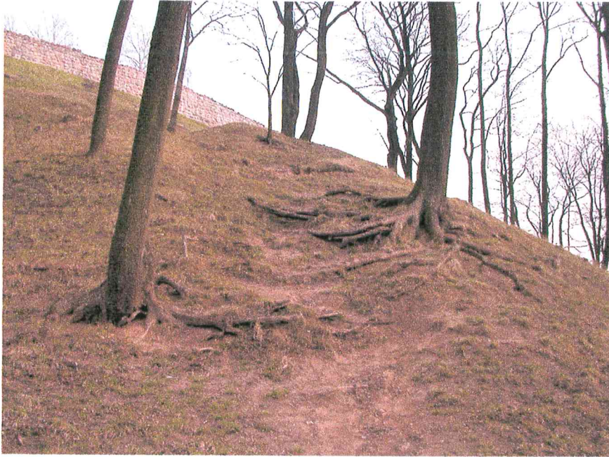
4 pav. Žemių išgraužos po medžių šaknimis 5-7 gręžinių zonoje.
