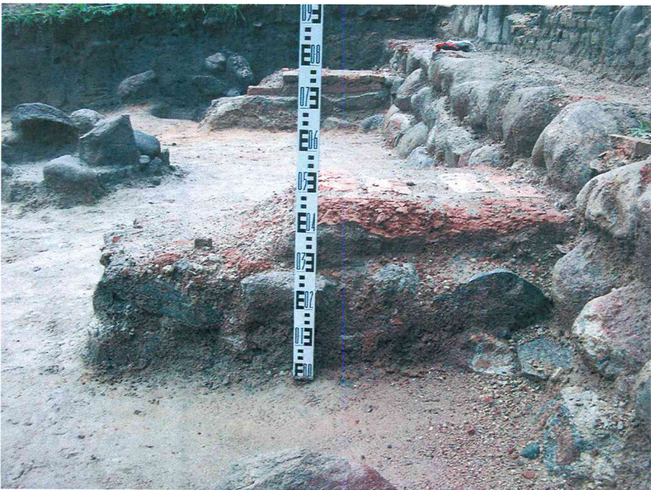
Nuotr. Nr.29. Perkasa Nr. 2 kontraforsas prie V sienelės.
