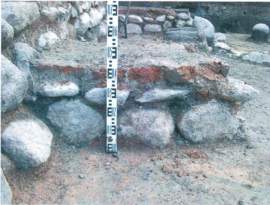
Nuotr. Nr.16. Perkasa Nr. 1 kontraforsas prie R sienelės.
