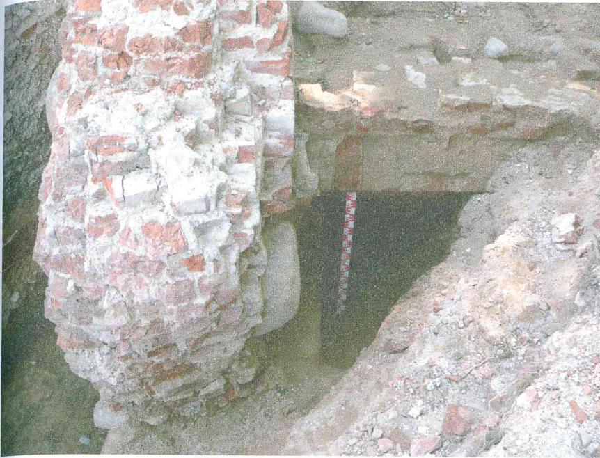
41. Rūmų pusrūsio skliauto ir švieslangio PV dalis. Vaizdas iš P.
