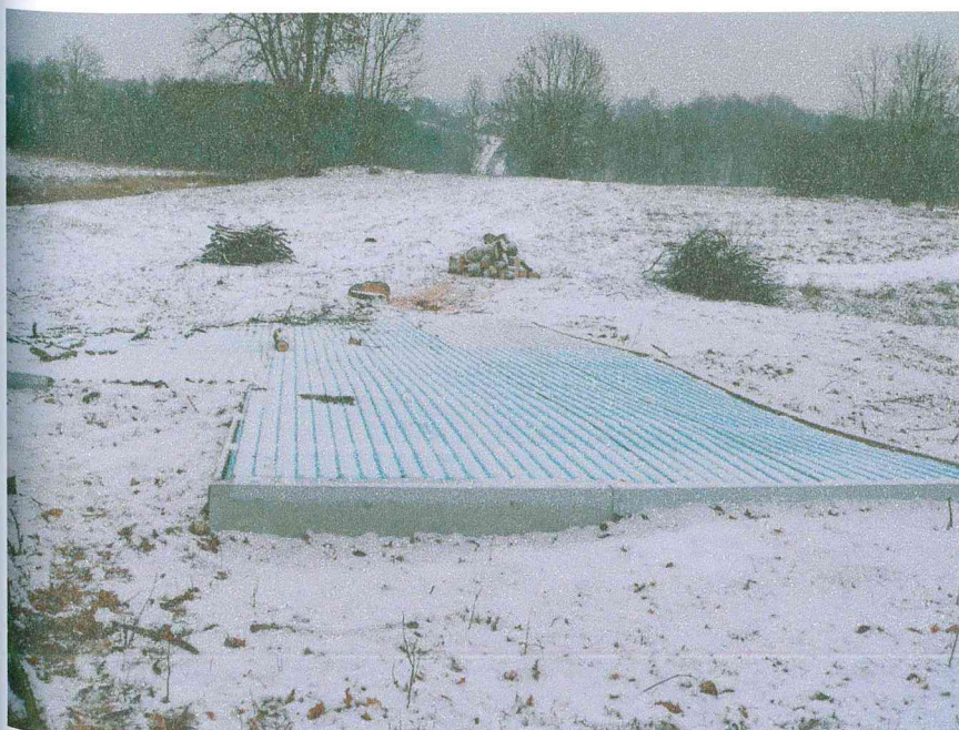
49. Laikinas perkastos perdengimas rūmų vietoje. Vaizdas iš V.
