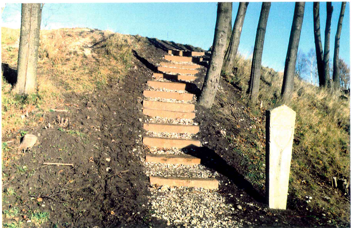
Sutvarkyta mechaninės erozijos vieta.
