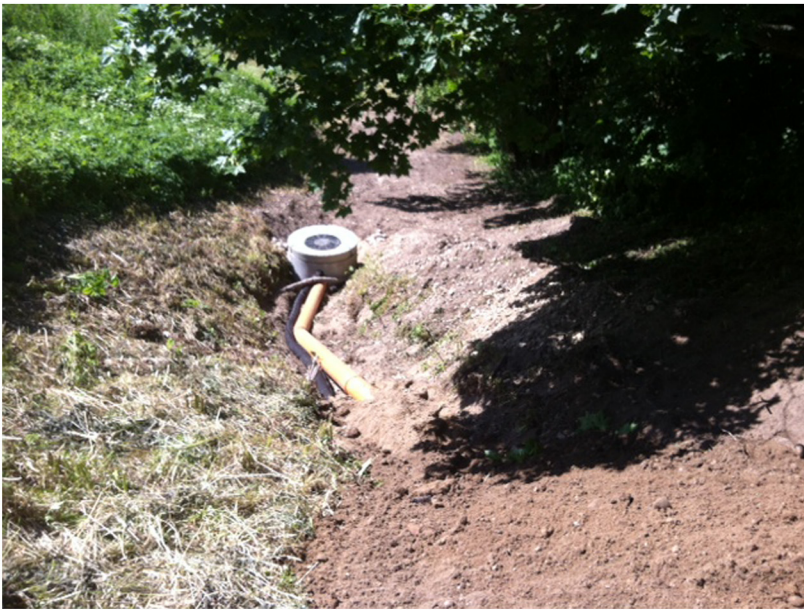
5. Trastos viršutinė atkarpa, naujai paklotas drenažinis vamzdis užpilamas atvežtiniu gruntu. Fotografuota iš rytų.
