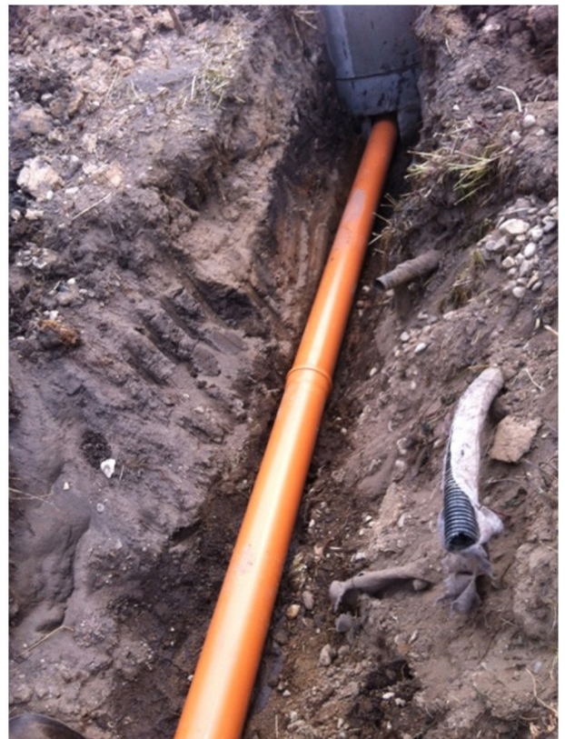
4. Piliakalnio šlaito šiaurinėje pusėje, viršutinėje trasos atkarpoje paklotas drenažinis vamzdis sujungtas su naujai įrangtu šuliniu Nr. 1. Fotografuota iš vakarų.
