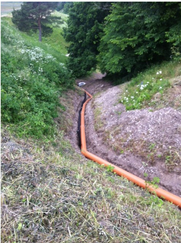
3. Piliakalnio šlaito šiaurinėje pusėje, viršutinėje trasos atkarpoje klojamas drenažinis vamzdis. Fotografuota iš rytų.
