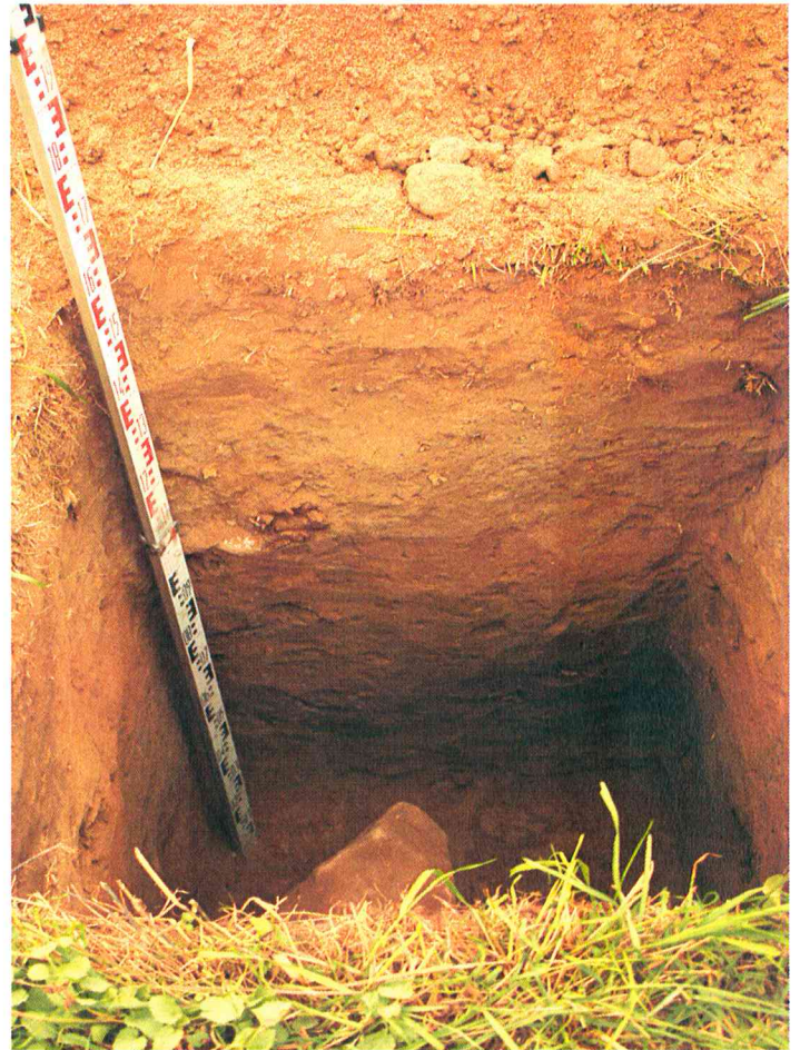
17. Šurfas Nr. 4 ties PK 1+50 pasiekus įžemį, vaizdas iš Š.
