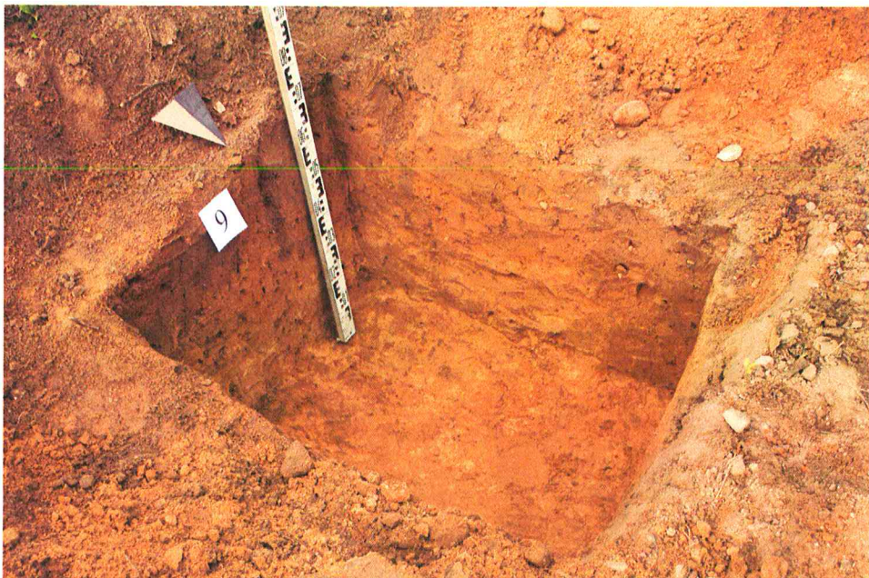
36. Šurfas Nr. 9 ties PK 4+00 pasiekus įžemį, vaizdas iš ŠR.
