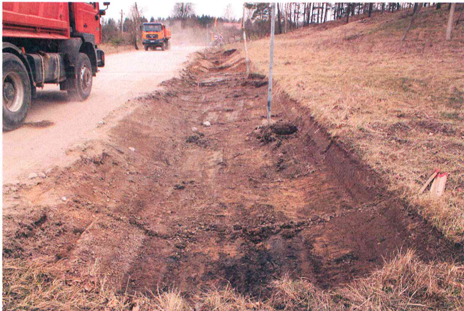
70. Nuimtas augalinis gruntas būsimojo kelio griovio vietoje nuo PK 0+20 iki PK 0+70, vaizdas iš R.
