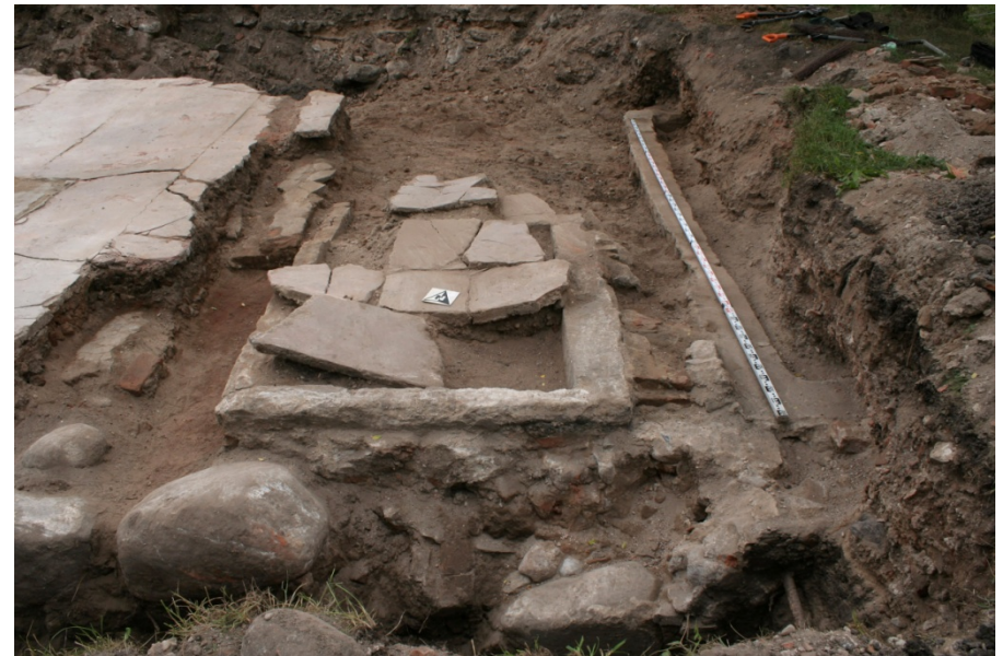
44. Betoninės konstrukcijos atkastų „žydų pirties“ griuvėsių SR dalyje. Vaizdas iš PR.
