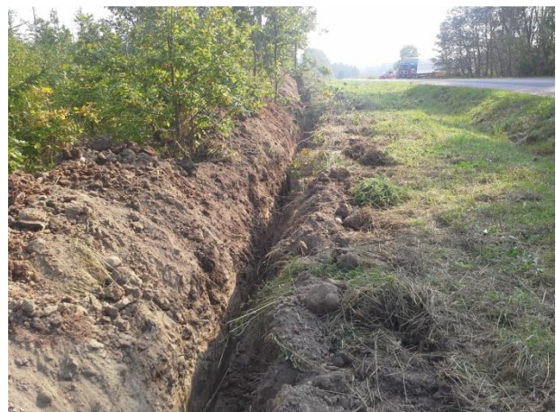
foto 54. Tranšėja kabeliui. Foto iš ŠV.
