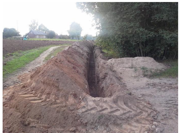
foto 48. Tranšėja kabeliui. Foto iš PV.
