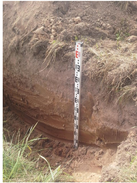
foto 50. Tranšėja kabeliui. Foto iš ŠV.
