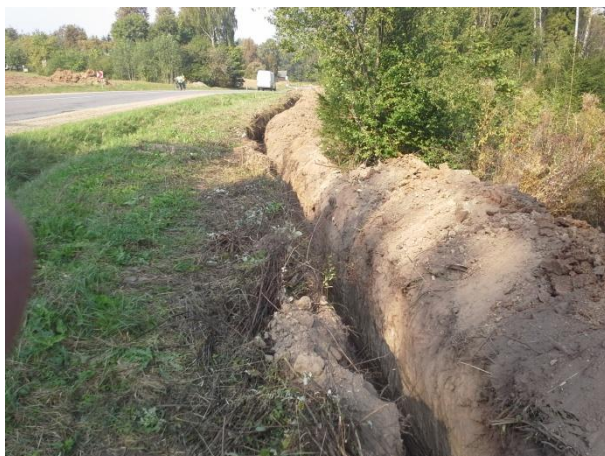
foto 53. Tranšėja kabeliui. Foto iš PR.
