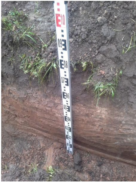
foto 49. Tranšėja kabeliui. Foto iš V.
