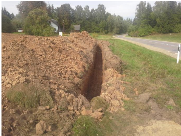
foto 51. Tranšėja kabeliui. Foto iš ŠR.
