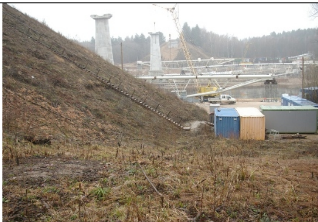
11 pav. Keltuvo ir laiptų bei žvalgymo vieta geležinkelio tilto teritorijoje iš V.
