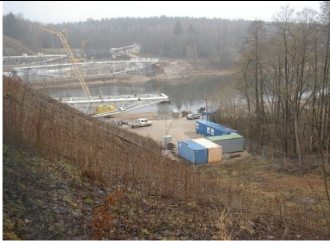
9 pav. Trečiosios (PR) poilsio aikštelės ir žvalgymų vieta tilto teritorijoje iš R.
