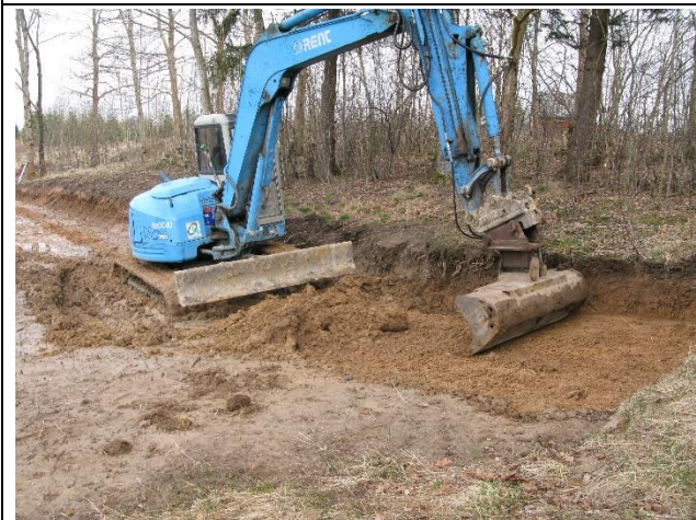
Nr. 3. Mechanizuotas paviršiaus kasimas.
