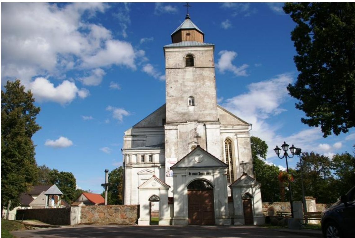
1 nuotr. Veliuonos Švč. Mergelės Marijos Ėmimo į dangų bažnyčia. Bendras vaizdas iš vakarų.
