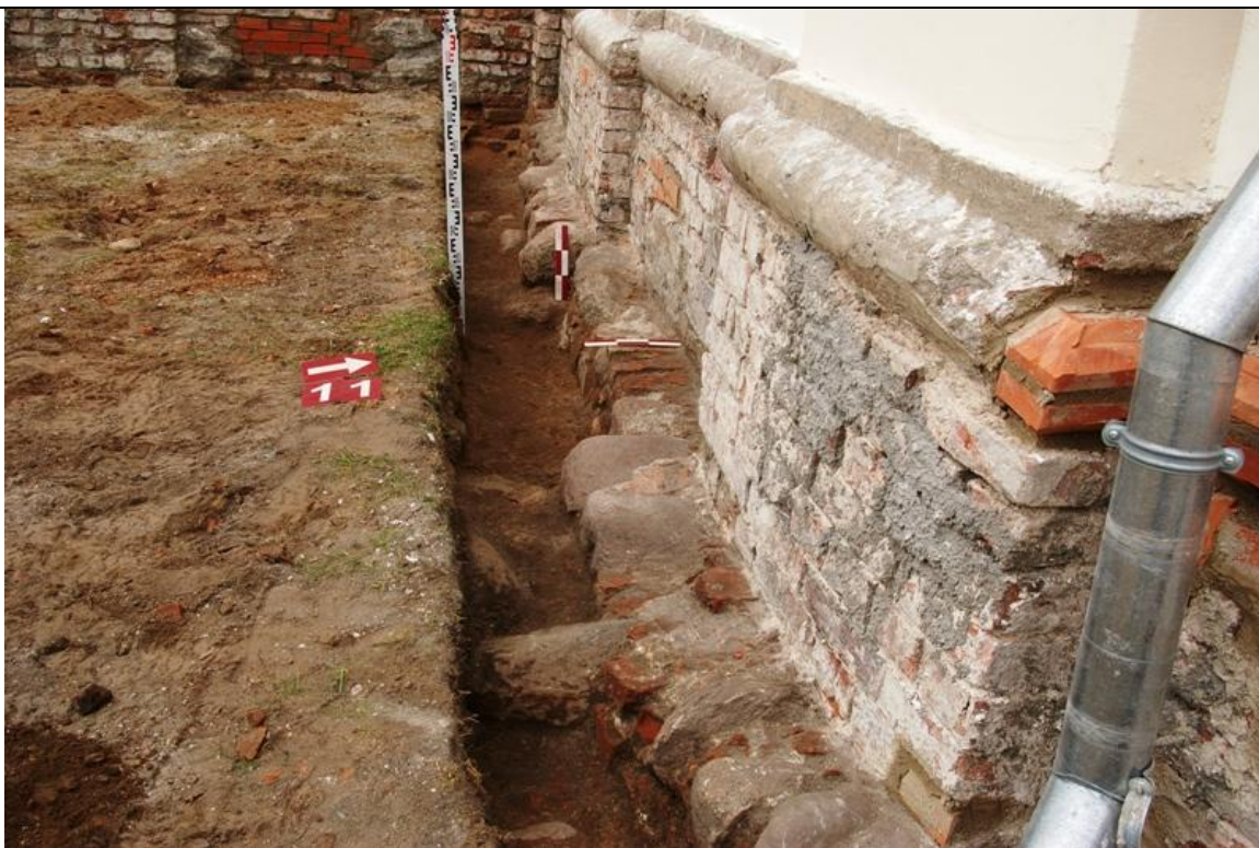
159 pav. Tranšėjos Nr. 11 vakarinė dalis, pašalinus nuogrindą. Pamato išplatinimas. Vaizdas iš R.
