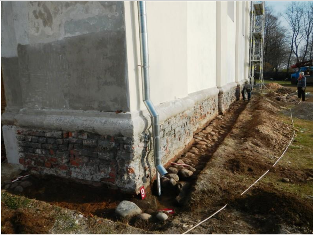
143 pav. Tranšėja Nr. 9. Atidengta nuogrinda. Vaizdas iš PV.
