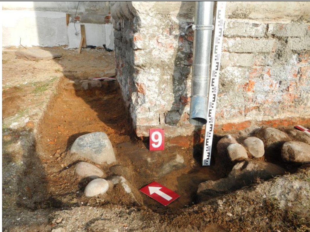
144 pav. Tranšėja Nr. 9. Bažnyčios kertinis akmuo ir kiti akmenys ties bažnyčios PV kampu. Vaizdas iš PV.
