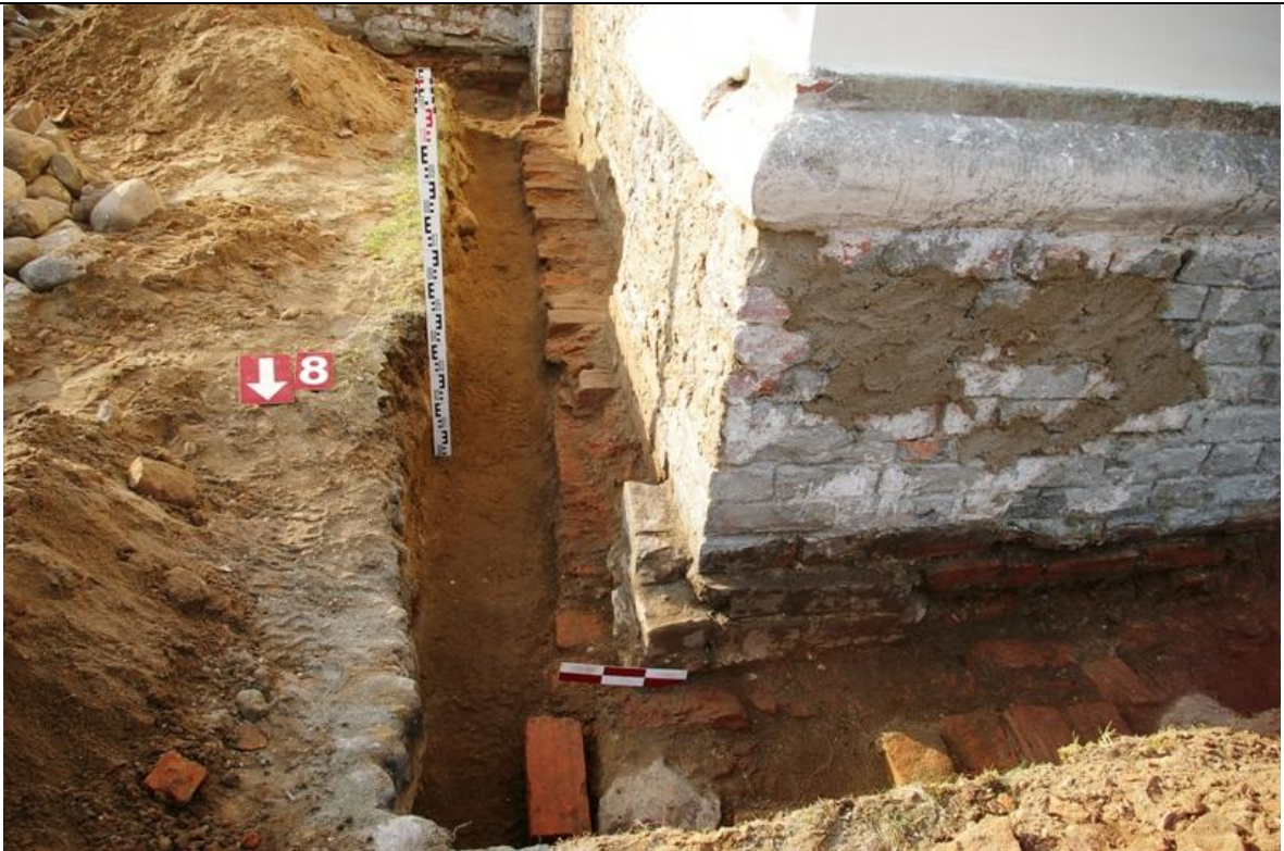
139 pav. Tranšėja Nr. 8. Bendras vaizdas, pašalinus nuogrindos akmenis. Vaizdas iš Š.
