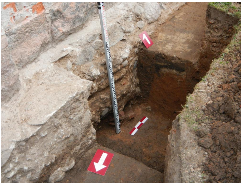
104 pav. Tranšėjos Nr. 1 pagilinimas būsimą lietaus nuotekų šulinėlio įrengimo vietoje. Vaizdas iš ŠV.
