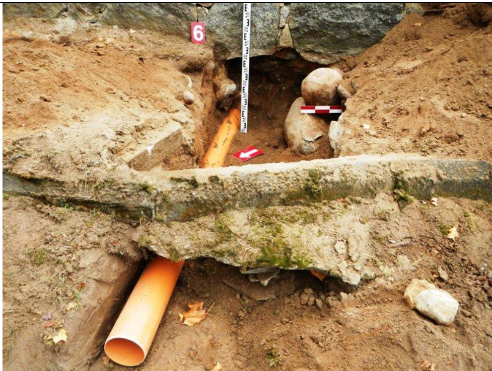
130 pav. Tranšėjos Nr. 6. Išvestas lietaus nuotekų vamzdis. Vaizdas iš ŠV.
