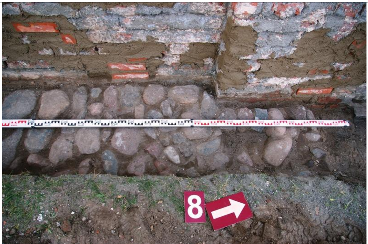
138 pav. Tranšėjos Nr. 8 pietinė dalis. Atidengta nuogrinda. Vaizdas iš R.
