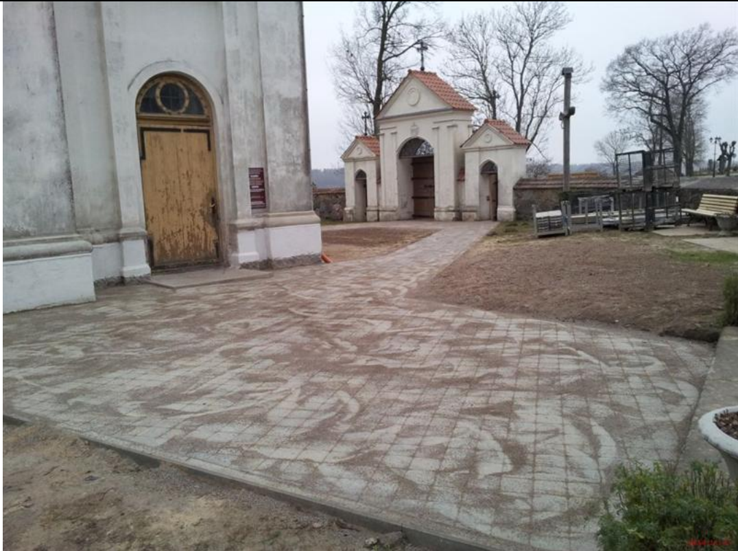
170 pav. Tranšėjos Nr. 14 vieta (aikštelė) ir tranšėjos Nr. 13 vieta (pėsčiųjų takas) po tyrimų, įrengus betono trinkelį dangą. Vaizdas iš ŠR.
