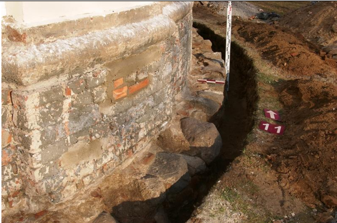
158 pav. Tranšėjos Nr. 11 vidurinė (rytinė) dalis, pašalinus nuogrindą. Pamato išplatinimas. Vaizdas iš P.
