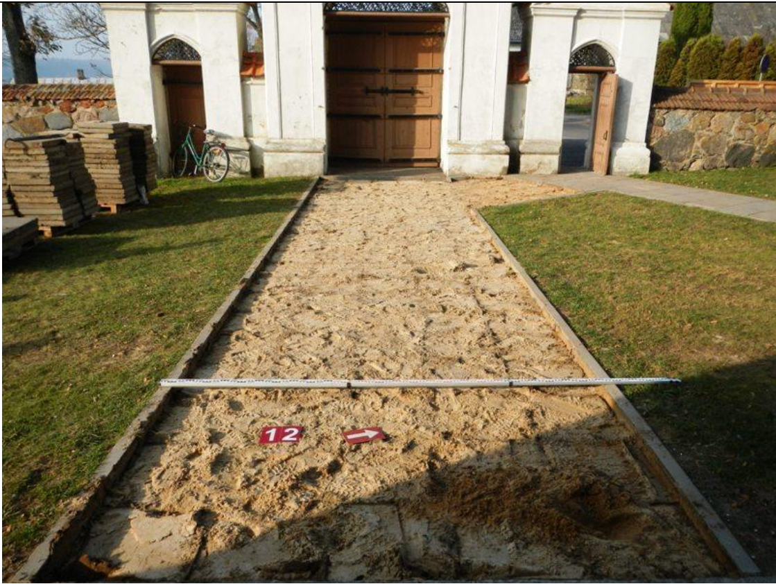
161 pav. Tranšėjos Nr. 12 bendras vaizdas iš R, nuėmus betonines tako plyteles.
