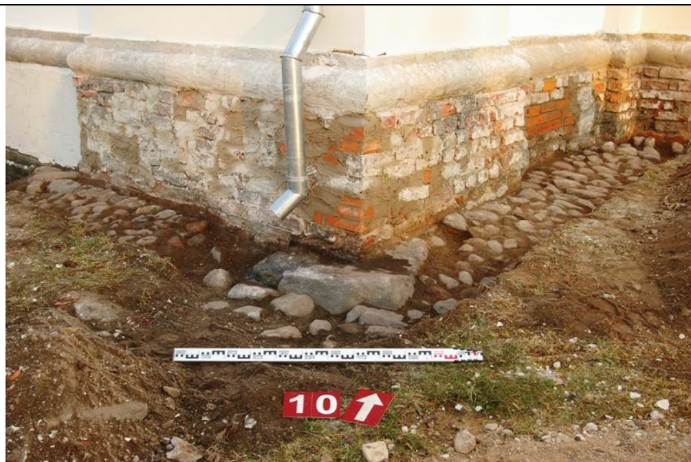
148 pav. Tranšėja Nr. 10. Atidengta nuogrinda. Vaizdas iš PR.
