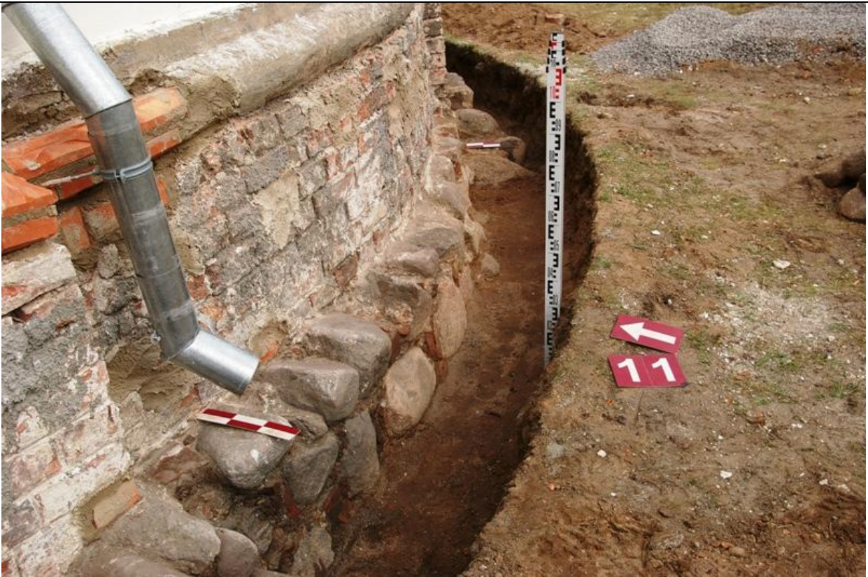
157 pav. Tranšėjos Nr. 11 pietrytinė dalis, pašalinus nuogrindą. Pamato išplatinimas. Vaizdas iš V.
