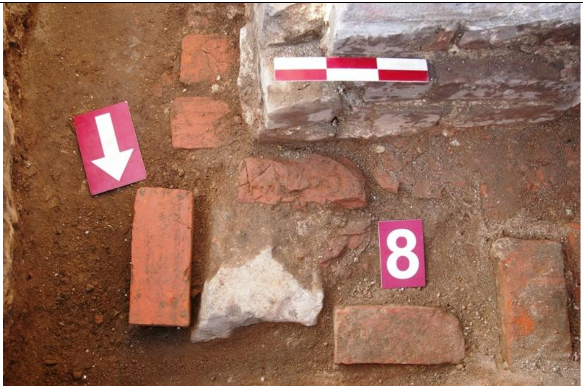
140 pav. Tranšėja Nr. 8. Pamato išplatinimas iš plytų ir akmenų. Vaizdas iš Š.
