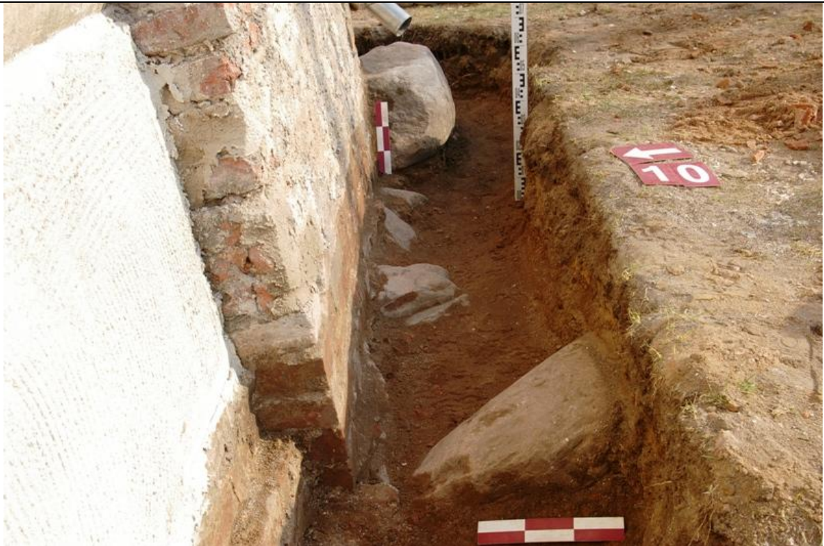
153 pav. Tranšėja Nr. 10. Akmenys, sustiprinantys bažnyčios pietrytinį kampą. Vaizdas iš V.
