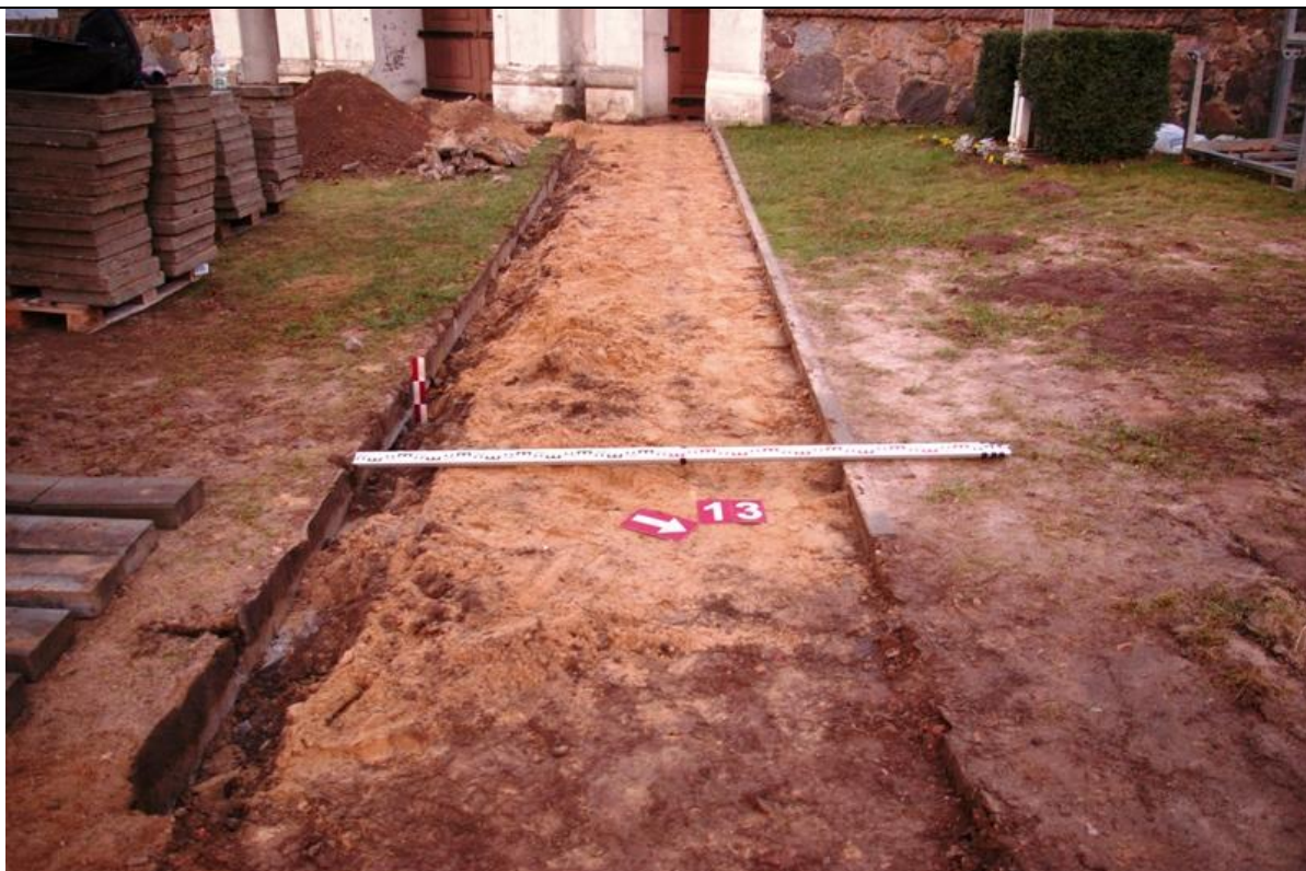
165 pav. Tranšėjos Nr. 13 bendras vaizdas iš ŠR, nuėmus betonines tako plyteles.
