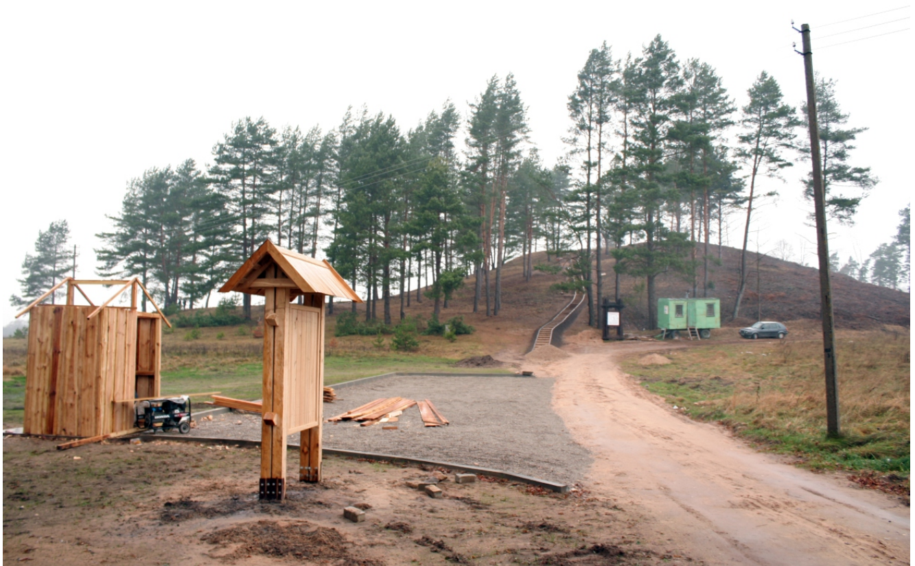
F.87. Infrastruktūros įrengimas Moškėnų, Laukupėnų piliakalnyje 2013 m. lapkritį. Vaizdas iš PR.
