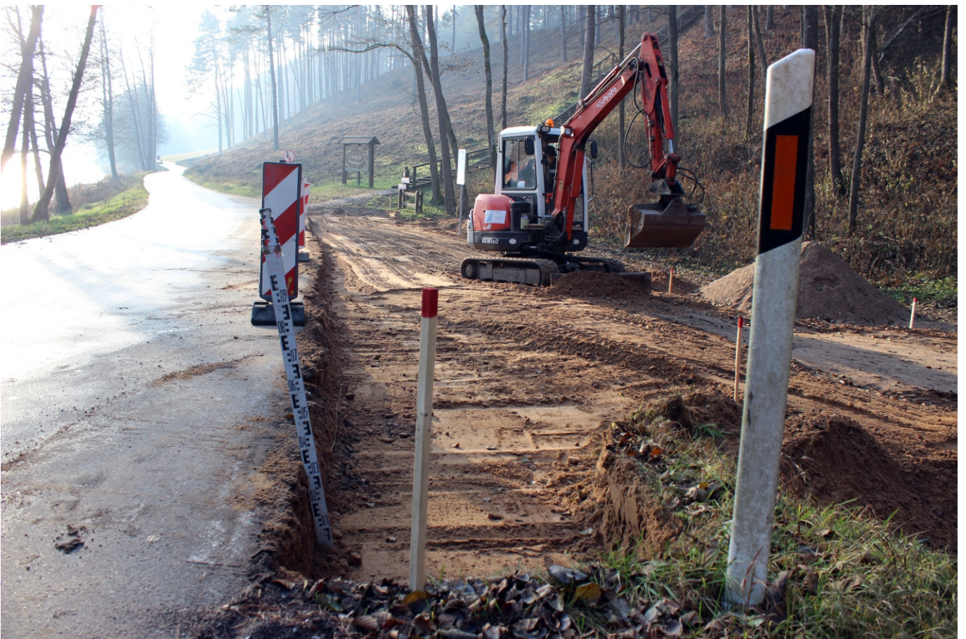
F.2. Šalinamas paviršinis sluoksnis kelio praplatėjimo bei nuvažos į automobilių stovėjimo aikštelę vietoje. Vaizdas iš Š.
