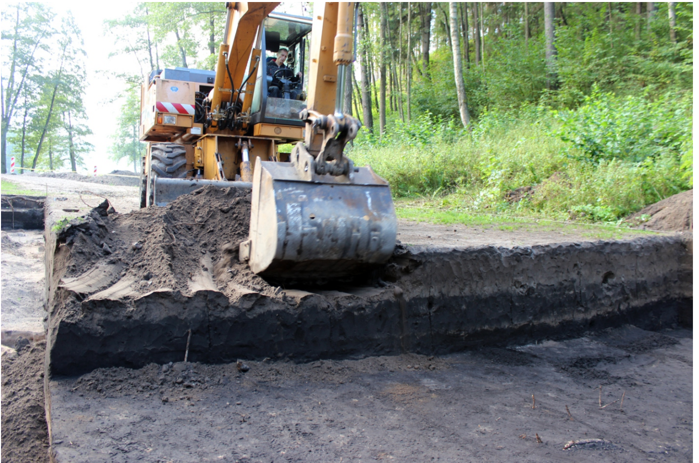
F.59. Mechanizuotai šalinamas viršutinis užslinkęs sluoksnis perkaso Nr.24 vietoje. Vaizdas iš Š.
