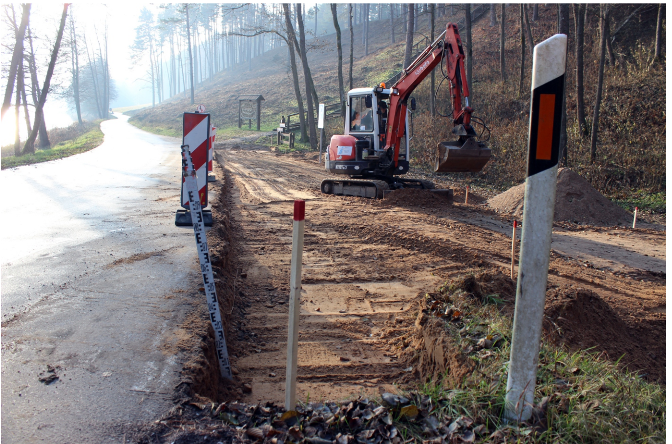
F.95. Šalinamas paviršinis sluoksnis kelio praplatėjimo bei nuvažos į automobilių stovėjimo aikštelę vietoje. Vaizdas iš Š.
