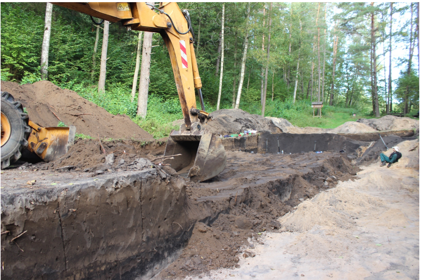
F.60. Mechanizuotai šalinamas viršutinis užslinkęs sluoksnis perkasu Nr.24-26 vietoje. Vaizdas iš R.
