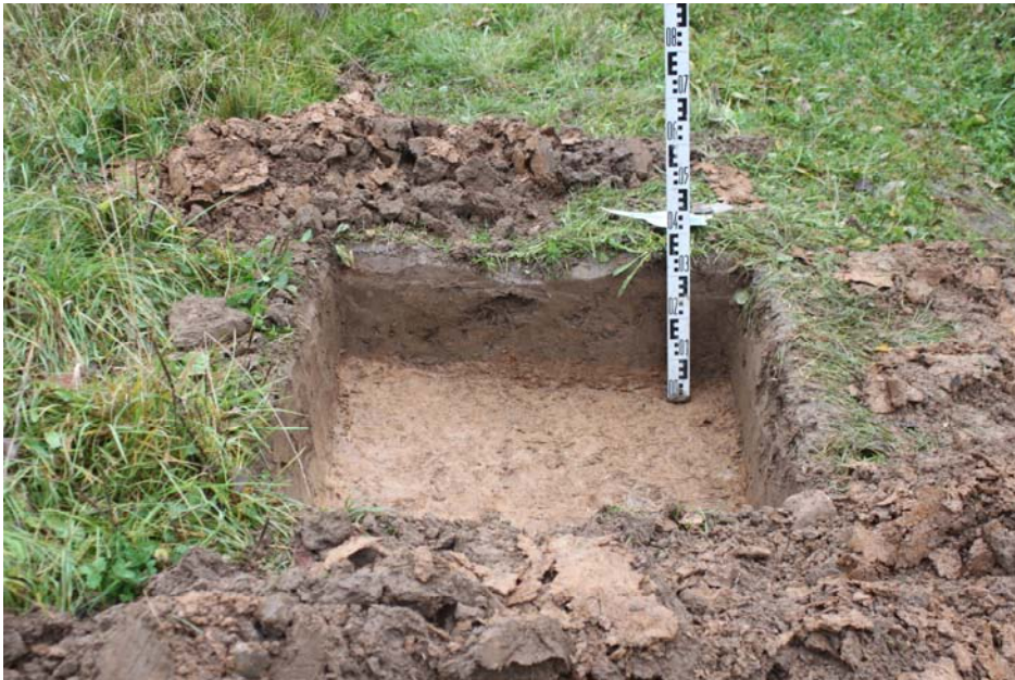
53. Šurfas Nr. 10 iš PV pusės.
