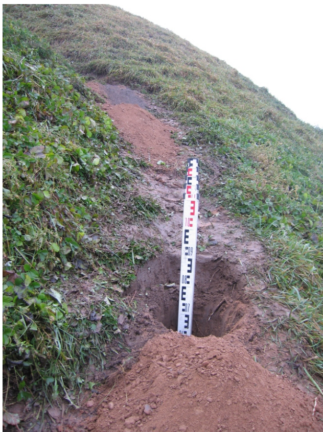
F.27-30 Archeologiniai žvalgymai. Išgręžtos vietos mediniams laiptų poliams.
