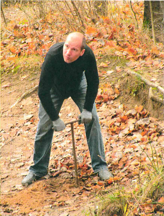
Gręžiamas gręžinys stendui įtvirtinti.
