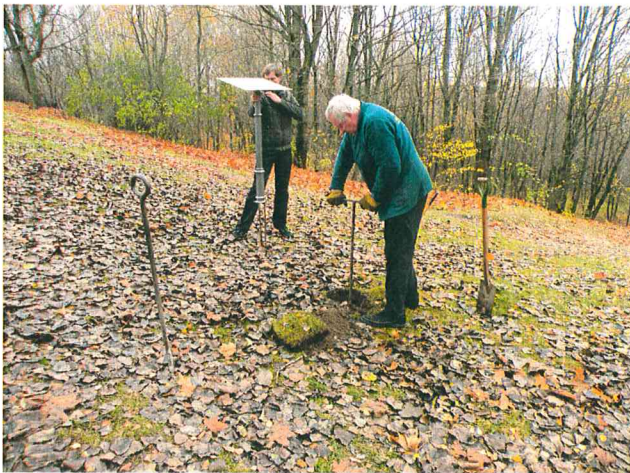
Gręžiamas gręžinys stendui įtvirtinti.
