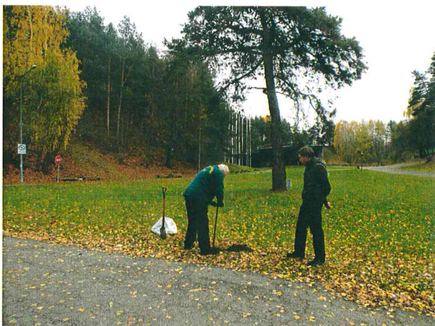
Gręžiamas gręžinys stendo tvirtinimui.
