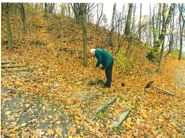
Gręžinys stendo įtvirtinimui.
