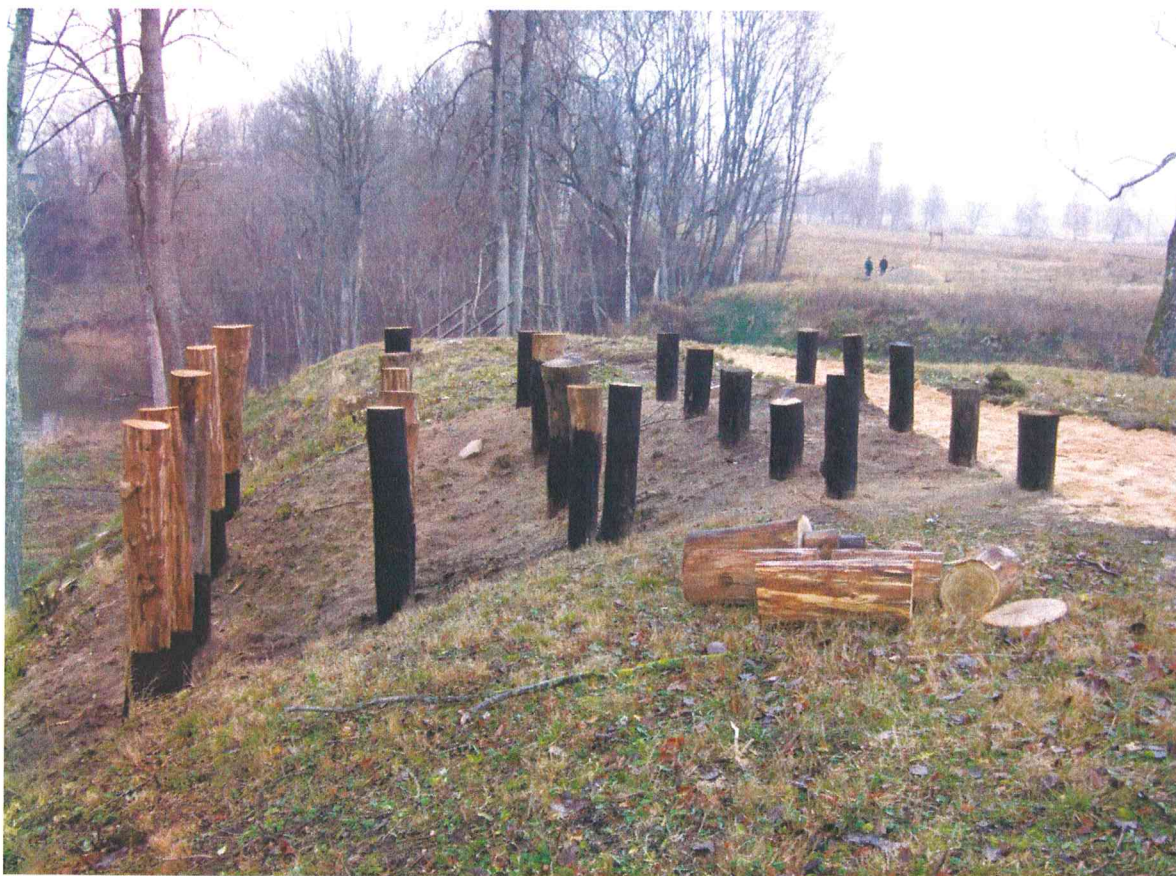
F 22. Gyvolių piliakalnio archeologiniai žvalgymai. Apžvalgos aištelės įrengimo darbai. Vaizdas iš P.
