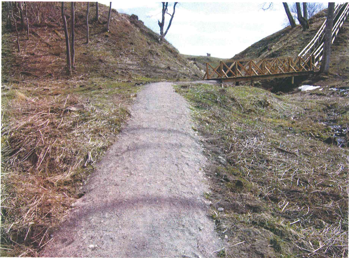
F 34. Gyvolių piliakalnio archeologiniai žvalgymai. Įrengtas tiltelis per bevardį upelį piliakalnio Š dalyje. Vaizdas iš Š.
