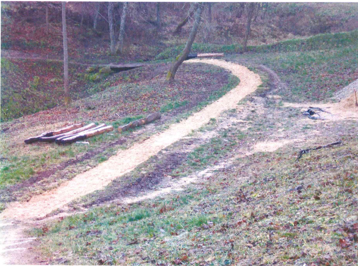
F 14. Gyvolių piliakalnio archeologiniai žvalgymai. Įrengiamas pėsčiųjų takas PR piliakalnio dalyje, atkarpa tarp tiltelio ir laiptų į piliakalnį. Užpiltas smėlio sluoksnis. Vaizdas iš ŠV.
