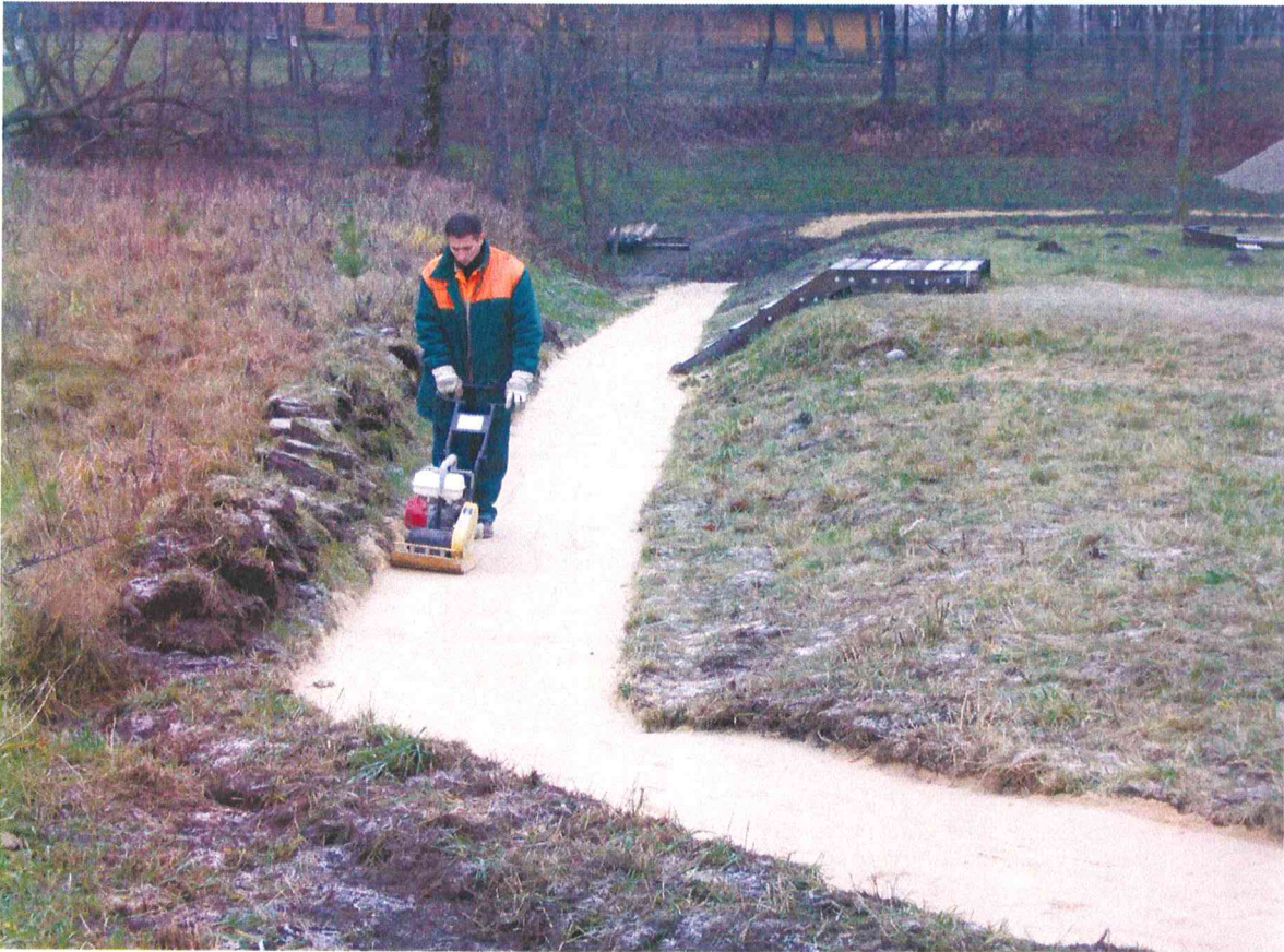
F 15. Gyvolių piliakalnio archeologiniai žvalgymai. Įrengiamas pėsčiųjų takas PR piliakalnio dalyje, atkarpa tarp tiltelio ir laiptų į piliakalnį. Užpilamas ir trombuojamas smėlio sluoksnis. Vaizdas iš ŠV.
