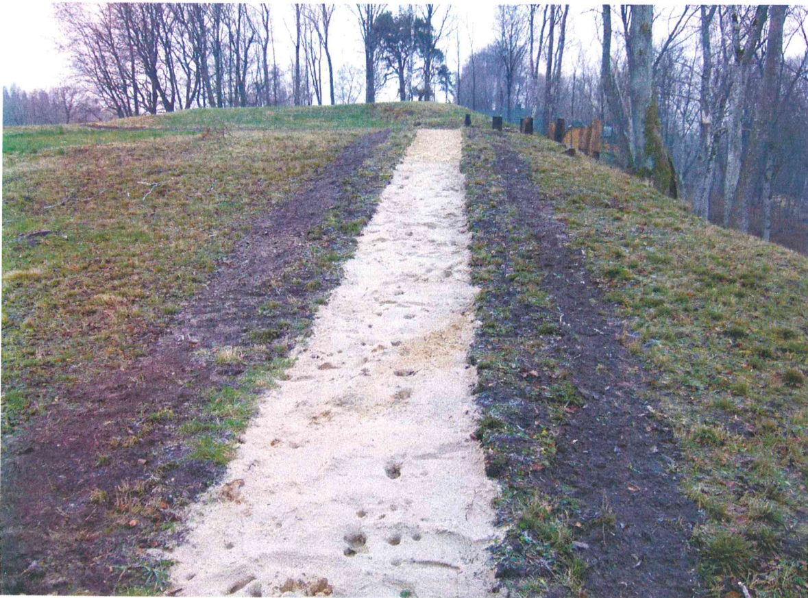
F 12. Gyvolių piliakalnio archeologiniai žvalgymai. Įrengiamas pėsčiųjų takas piliakalnio aikštelės centrinėje dalyje. Užpiltas smėlio sluoksnis. Vaizdas iš Š.
