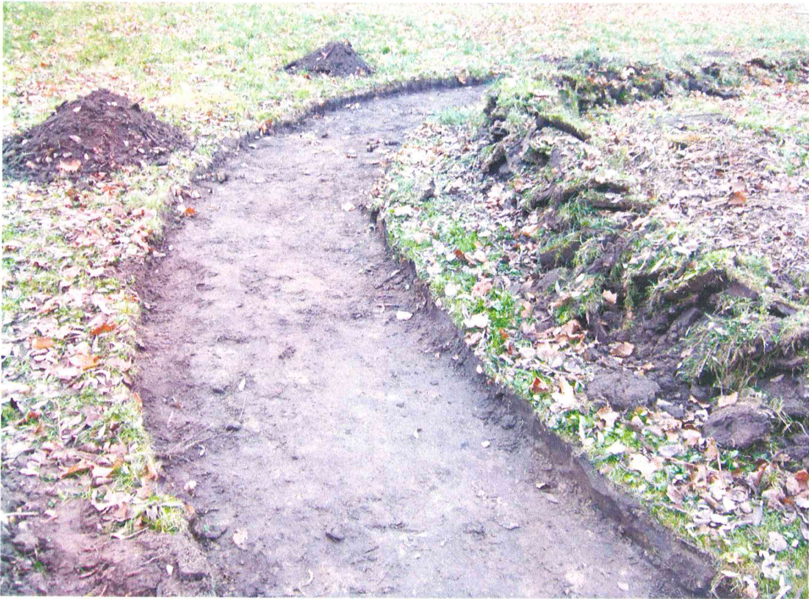
F 5. Gyvolių piliakalnio archeologiniai žvalgymai. Įrengiamas pėsčiųjų takas PR piliakalnio dalyje, atkarpa tarp tiltelio ir laiptų į piliakalnį. Nuimtas velėnos sluoksnis. Vaizdas iš ŠV.
