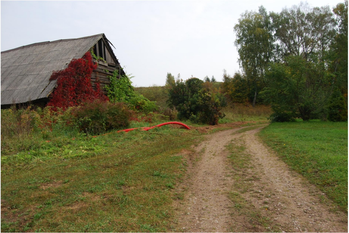
3. Šurfo Nr. 10 vieta, ties kuria baigiasi užkasta kabelio futliaro tranšėja
