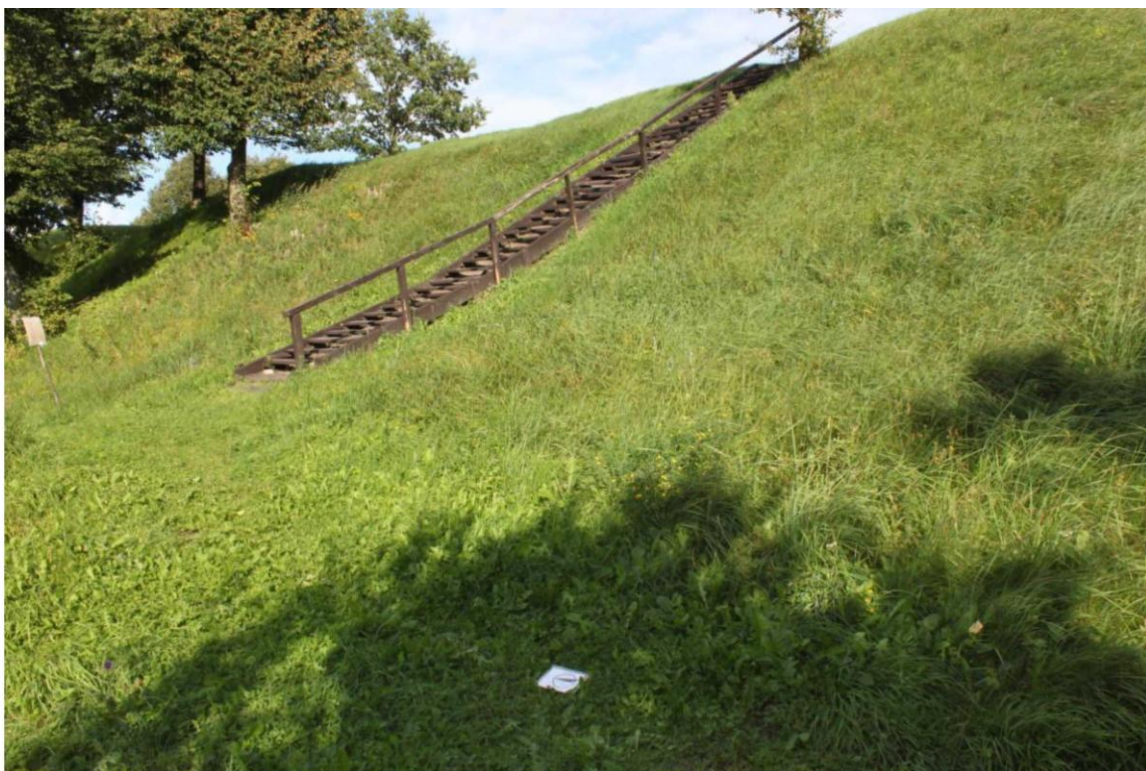
Fotografija Nr. 3 Būsimo tako bei laiptų į pirmojo priešpilio pylimą aplinkos vaizdas iš PV pusės.
