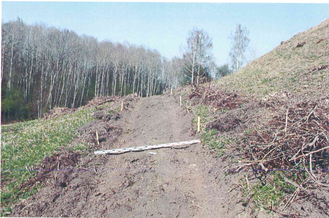
Fotografija Nr. 30 Piliakalnio pašlaitėje įrenginėjamo pėsčiųjų tako vietos vaizdas nuėmus velėną. Vaizdas iš PV pusės.
