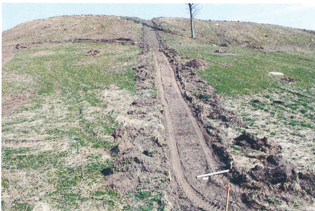
Fotografija Nr. 14 ŠV piliakalnio pašlaitėje įrenginėjamo terasuoto tako vietos vaizdas nuėmus velėną. Vaizdas iš V pusės.
