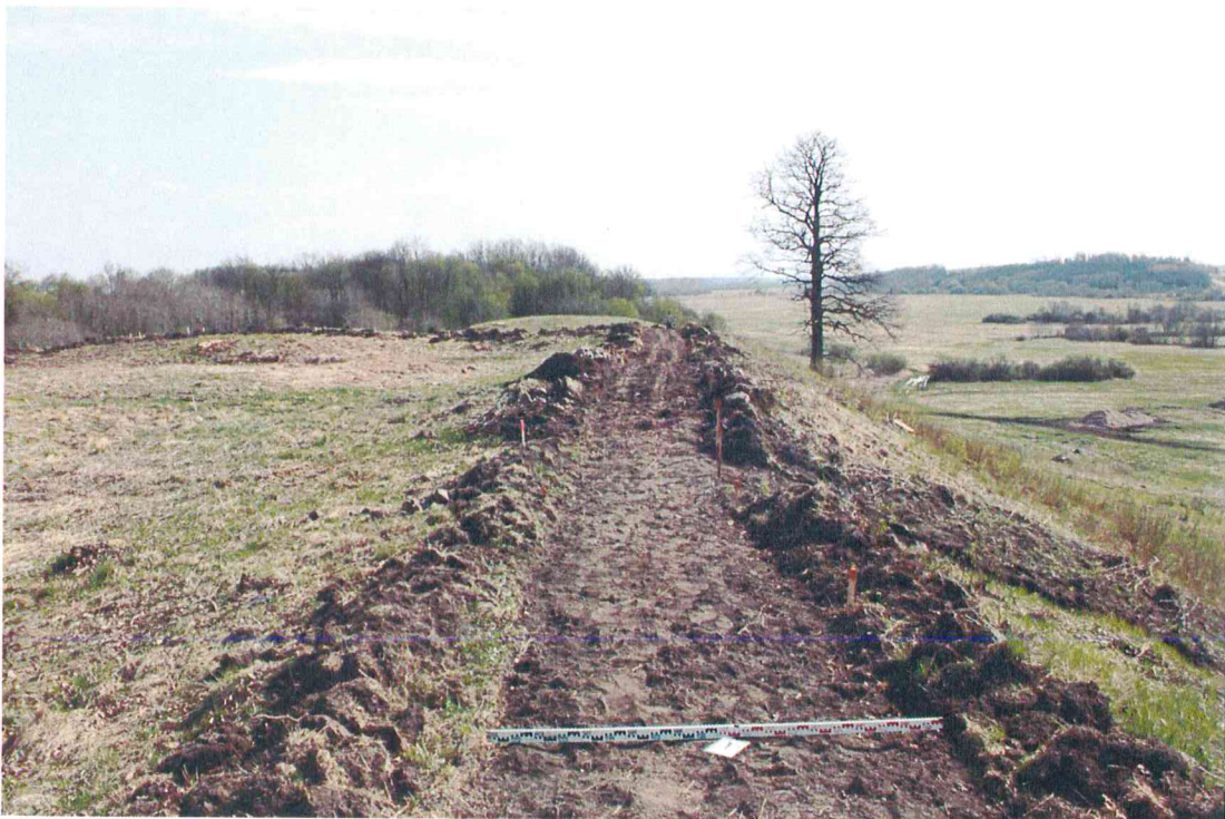
Fotografija Nr. 26 Piliakalnio aikštelėje įrenginėjamo pėsčiųjų tako vietos vaizdas nuėmus velėną. Vaizdas iš ŠV pusės.
