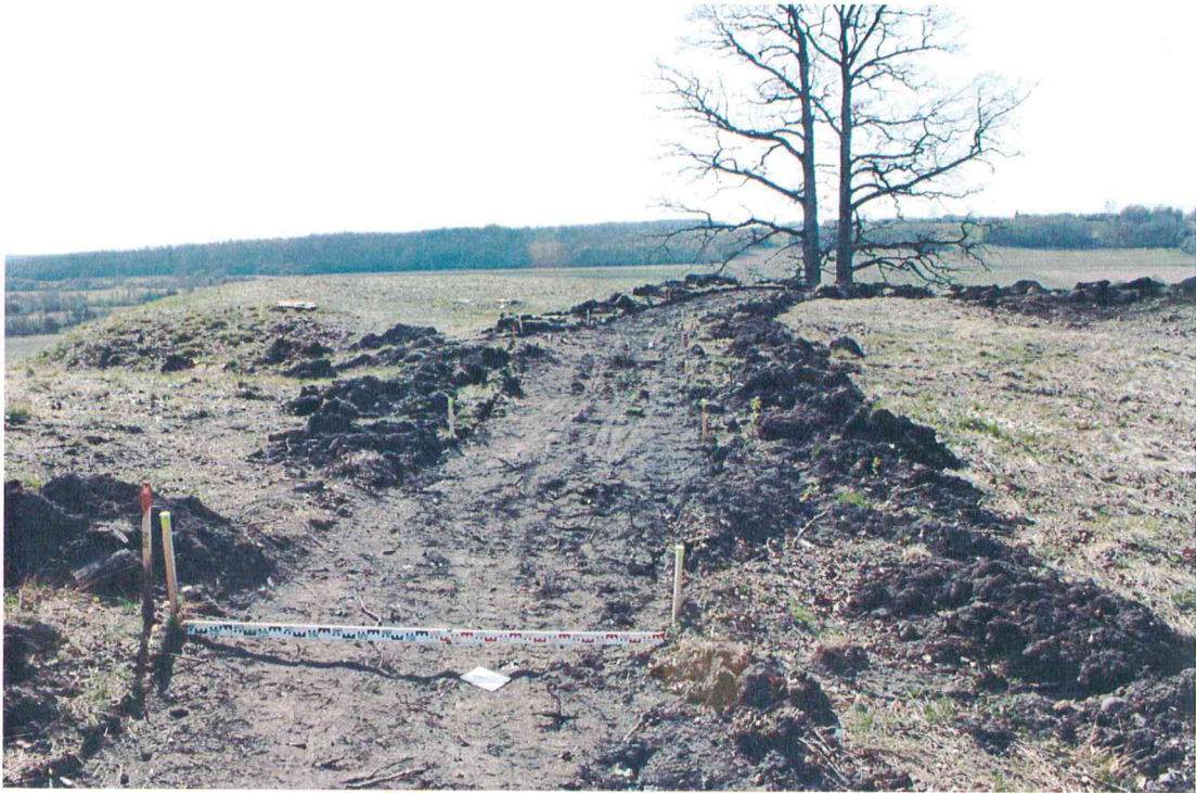
Fotografija Nr. 19 Piliakalnio aikštelėje įrenginėjamo pėsčiųjų tako vietos vaizdas nuėmus velėną. Vaizdas iš ŠR pusės.
