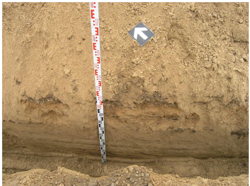
33. Tranšėja tarp šurfių 1 ir 2. Sienelės pjūvis. Vaizdas iš pietvakarių.
