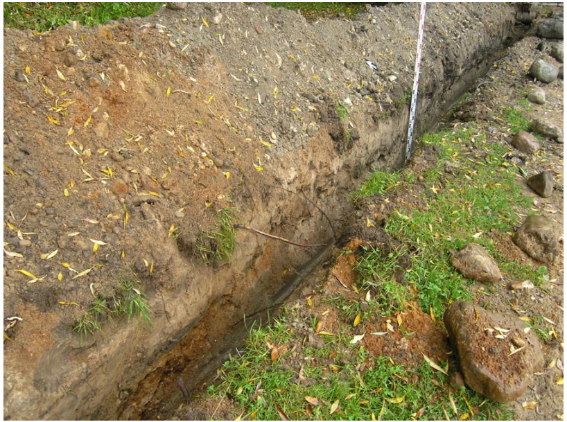
42. Tranšējos dalis ģ PR nuo transformatorinēs vietas. Vaizdas iš vakarų.
