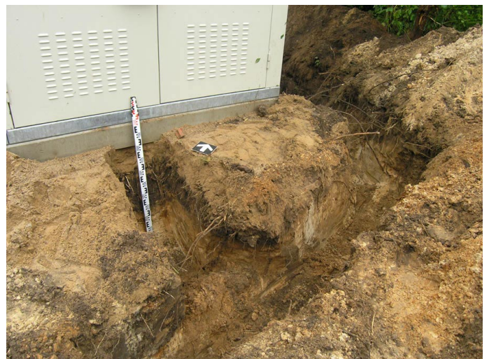
52. Tranšēja transformatorinēs ižeminimui. Vaizdas iļ pietryčiu.
