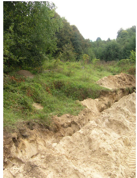
10. Tranšėja el. kabeliams Piliakalnio gatvėje. Vaizdas iš vakarų.
