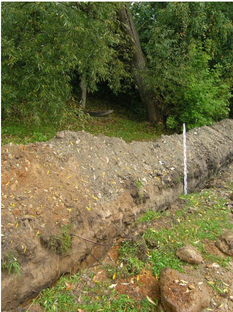
43. Tranšējos dalis ģ PR nuo transformatorinēs vietas. Vaizdas iš vakarų.
