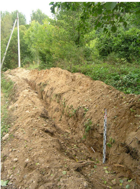
11. Tranšėja el. kabeliams Piliakalnio gatvėje. Vaizdas iš pietų.
