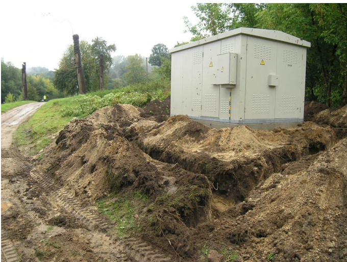
63. Tranšėja transformatorinės įžeminimui. Vaizdas iš pietų.
