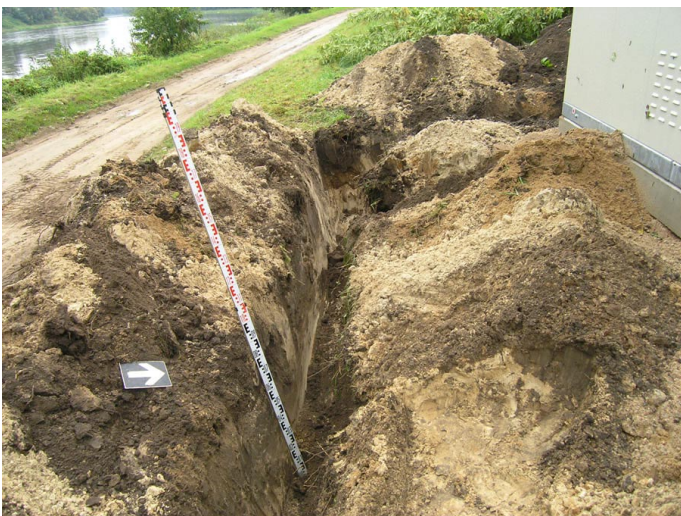
57. Tranšėja transformatorinės įžeminimui. Vaizdas iš rytų.
