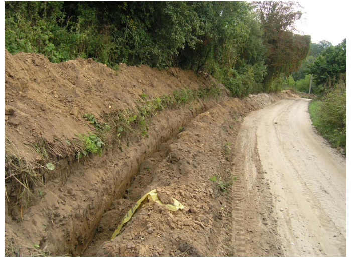
8. Tranšėja el. kabeliams Piliakalnio gatvėje. Vaizdas iš vakarų.
