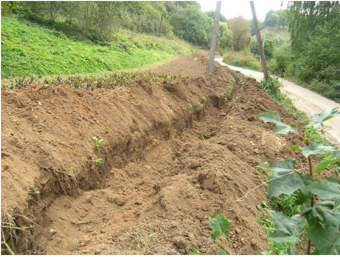
7. Tranšėja el. kabeliams Piliakalnio gatvėje. Vaizdas iš vakarų.
