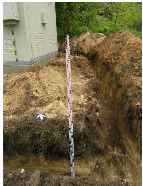
56. Tranšėja transformatorinės įžeminimui. Vaizdas iš pietų.
