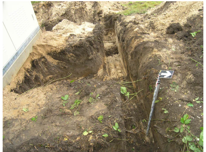
62. Tranšėja transformatorinės įžeminimui. Vaizdas iš rytų.
