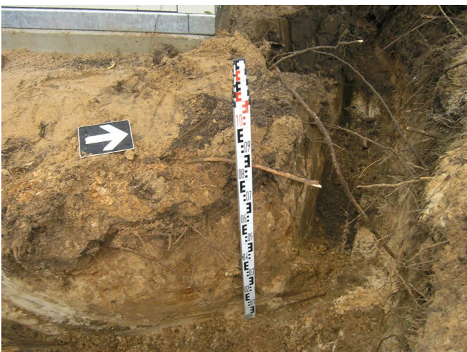
51. Tranšēja transformatorinēs ižeminimui. Sienelēs pjūvis. Vaizdas iļ rytu.
