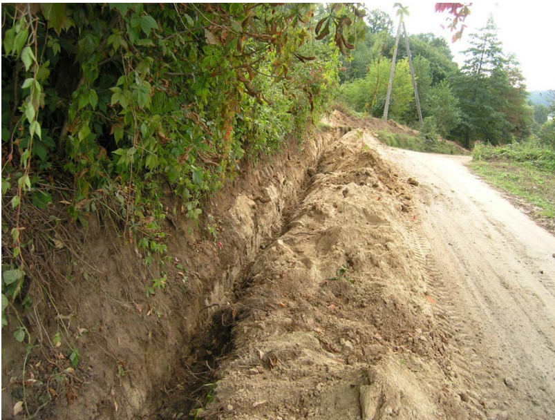
9. Tranšėja el. kabeliams Piliakalnio gatvėje. Vaizdas iš vakarų.
