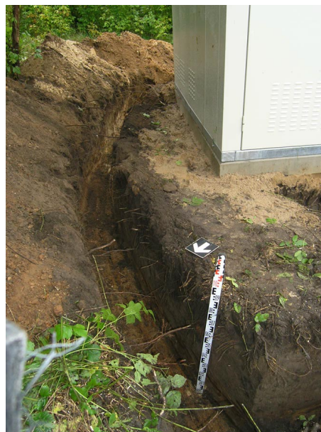
46. Tranšēja transformatorinēs ģžeminimui. Vaizdas iš šiaurēs.
