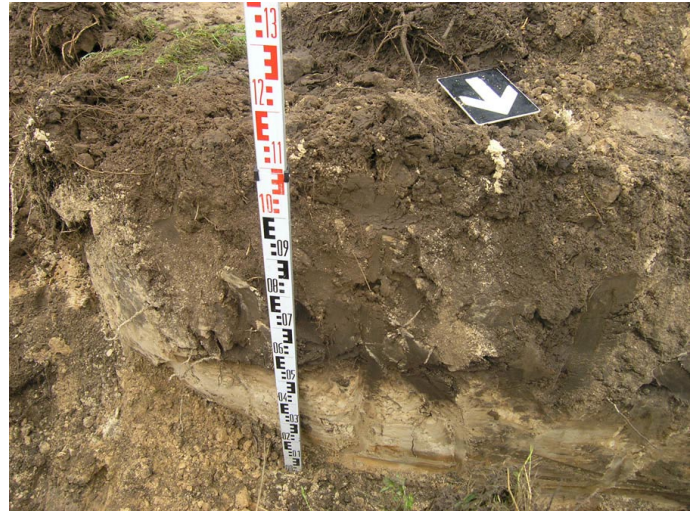
54. Tranšėja el. kabeliui prie transformatorinės. Sienelės pjūvis. Vaizdas iš šiaurės.
