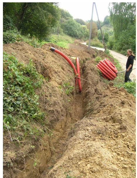
6. Tranšēja el. kabeliams Piliakalnio gatvėje. Vaizdas iš vakaru.
