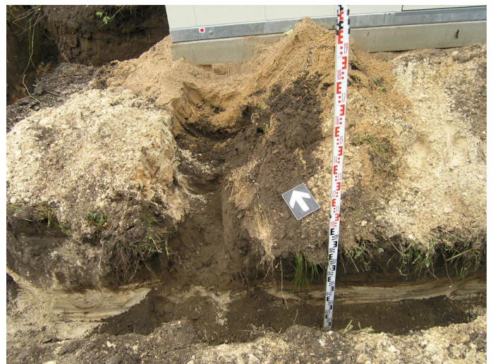
58. Tranšėja transformatorinės įžeminimui. Vaizdas iš pietų.
