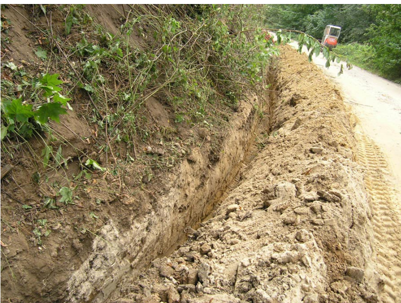
5. Tranšēja el. kabeliams Piliakalnio gatvėje. Vaizdas iš vakaru.
