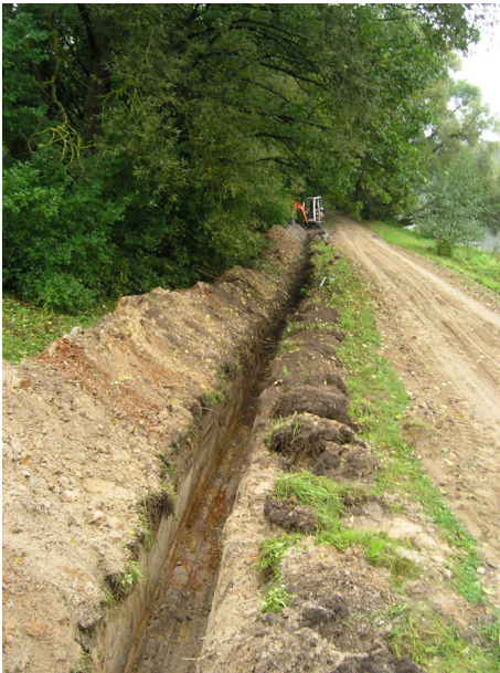
41. Tranšējos dalis ģ PR nuo transformatorinēs vietas. Vaizdas iš vakarų.
