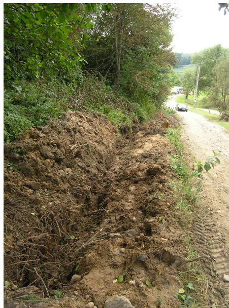
12. Tranšėja el. kabeliams Piliakalnio gatvėje. Vaizdas iš vakarų.
