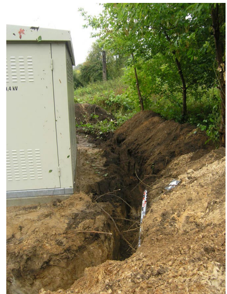
50. Tranšēja transformatorinēs ižeminimui. Vaizdas iļ pietryčiu.
