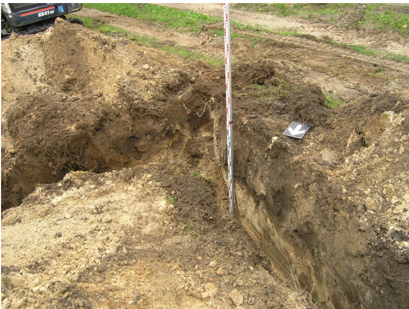
55. Tranšėja transformatorinės įžeminimui. Sienelės pjūvis. Vaizdas iš šiaurės rytų.
