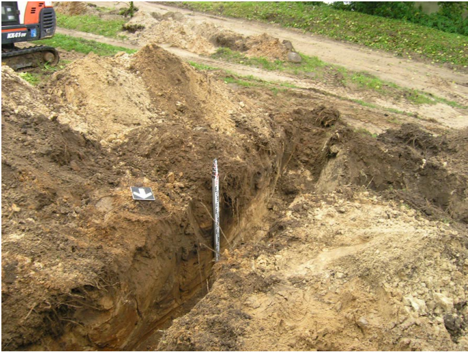
53. Tranšėja el. kabeliui prie transformatorinės. Vaizdas iš šiaurės.
