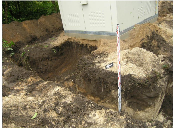
60. Tranšėja transformatorinės įžeminimui. Vaizdas iš vakarų.
