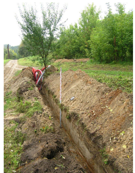
40. Tranšėjos dalis į PR nuo transformatorinės vietos. Vaizdas iš pietryčių.
