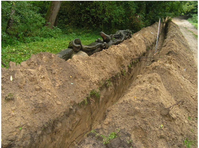
44. Tranšējos dalis ģ PR nuo transformatorinēs vietas. Vaizdas iš vakarų.
