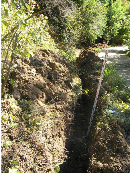
3. Tranšēja el. kabeliams Piliakalnio gatvėje. Vaizdas iš vakaru.
