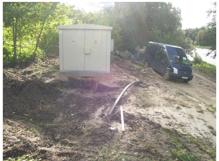
64. Per saugomą piliakalnio papėdės gyvenvietės sluoksnį (po juo) pragręžtas vamzdis kabeliui ties transformatorine. Bendras vaizdas iš šiaurės rytų.
