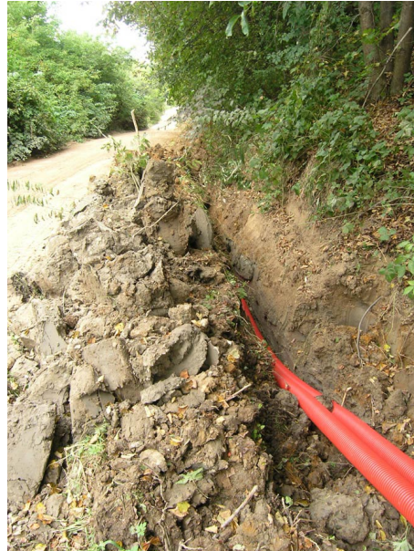
4. Tranšēja el. kabeliams Piliakalnio gatvėje. Vaizdas iš rytu.
