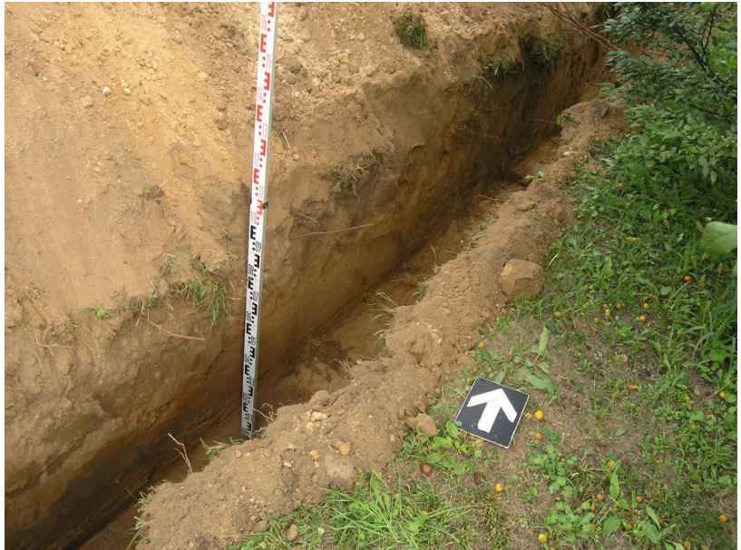
2. Tranšēja el. kabeliams Saulės gatvėje, sienelē pjūvis. Vaizdas iš pietryčiu.
