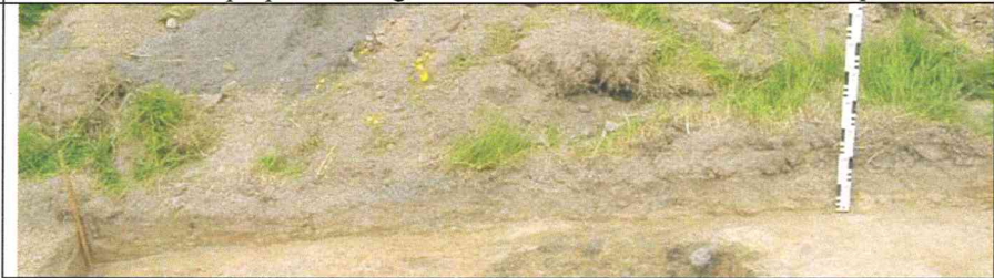
182 nuotr.: Perkastos Nr. 4 ŠV sienelės PV dalies vaizdas iš PR pusės.
