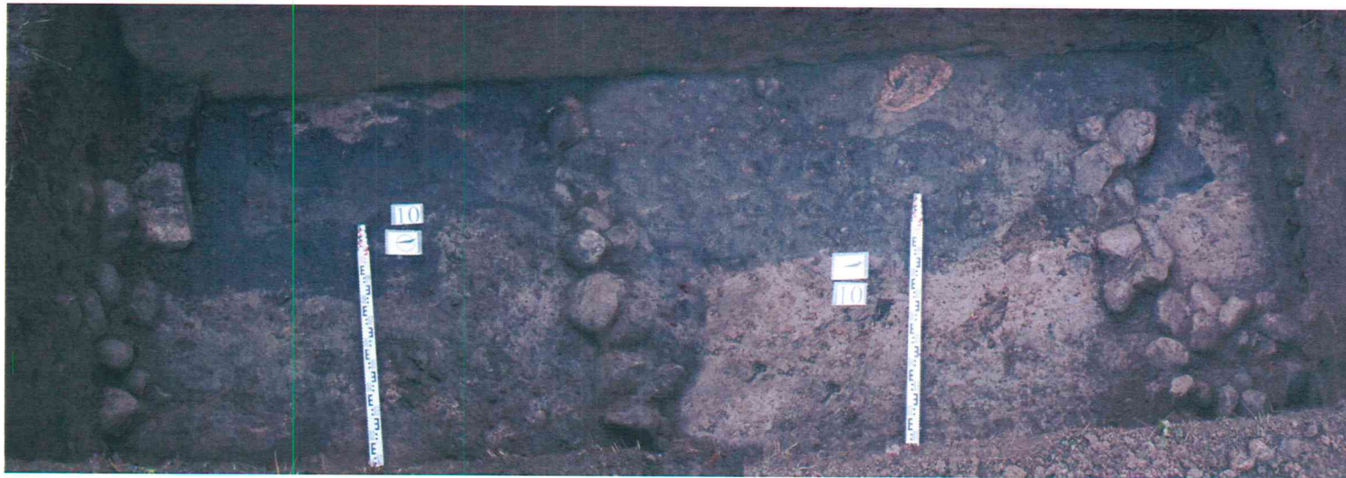
Fotografija Nr. 136 Iki projekcinio gylio iširtos perkamos Nr. 10 bendras dugno vaizdas iš viršaus.
