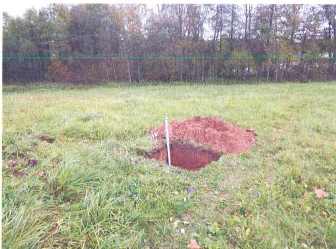
Fot 214 Sužionys. Šurfas Nr. 3, bendras vaizdas nuo PV
