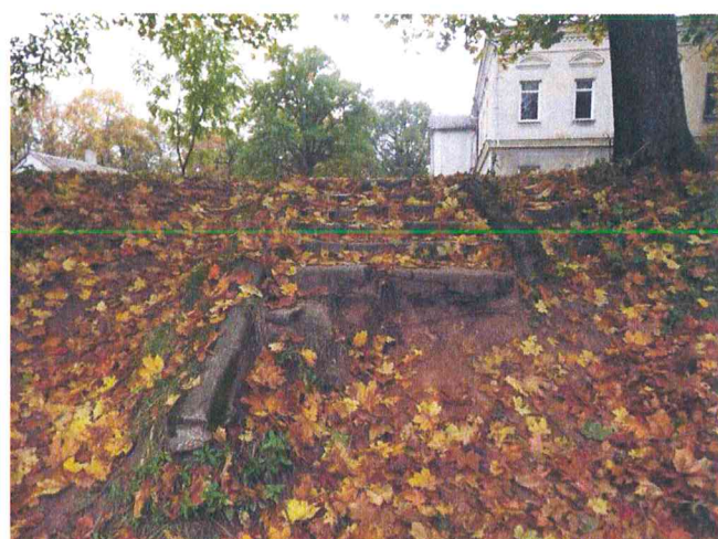
Fot 70 Buivydiškės. Laiptai į dvaro parką, vaizdas nuo PR
