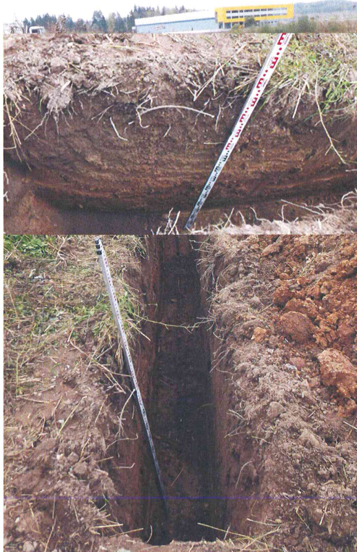
Pav. 1 Galinė. 2011 m. žvalgyta dujotiekio tranšėja Galinės gatvės kelkraštyje
