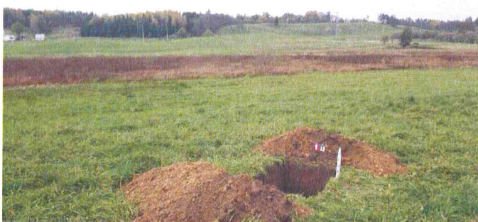
Fot. 29 Mažoji Riešė. Šurfas Nr. 6, bendras vaizdas nuo PV
