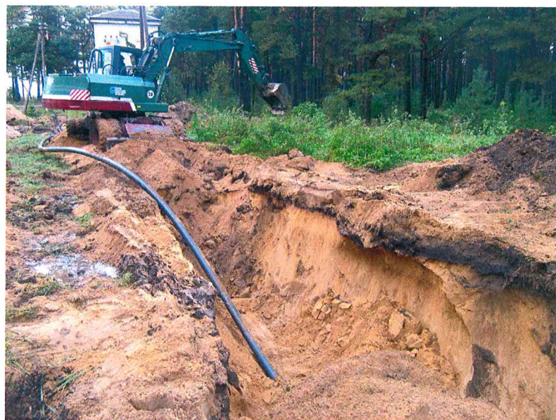
8 nuotr. Tranšėjos Nr. 2 atkarpa A pasiekus projektinį gylį ir dalinai užkasus vamzdį iš PV pusės.
