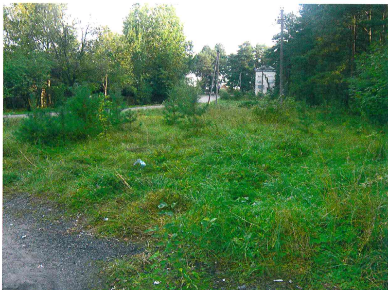
2 nuotr. Vandentiekio trasos tiesimo vieta (tranšėjos Nr. 1 atkarpos B ir tranšėjos Nr. 2 atkarpos A vieta) iki darbų pradžios iš PV pusės.
