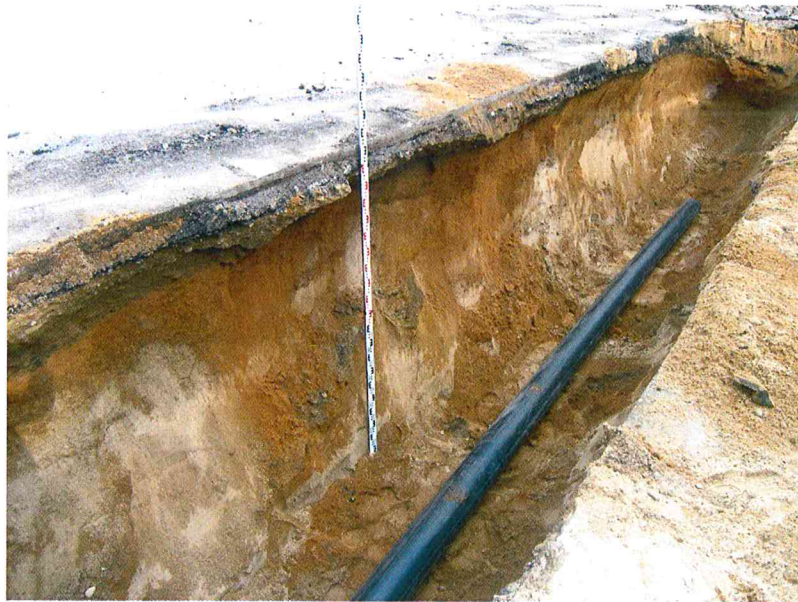
4 nuotr. Tranšėjos Nr. 1 atkarpa A pasiekus projektinį gylį iš P pusės.
