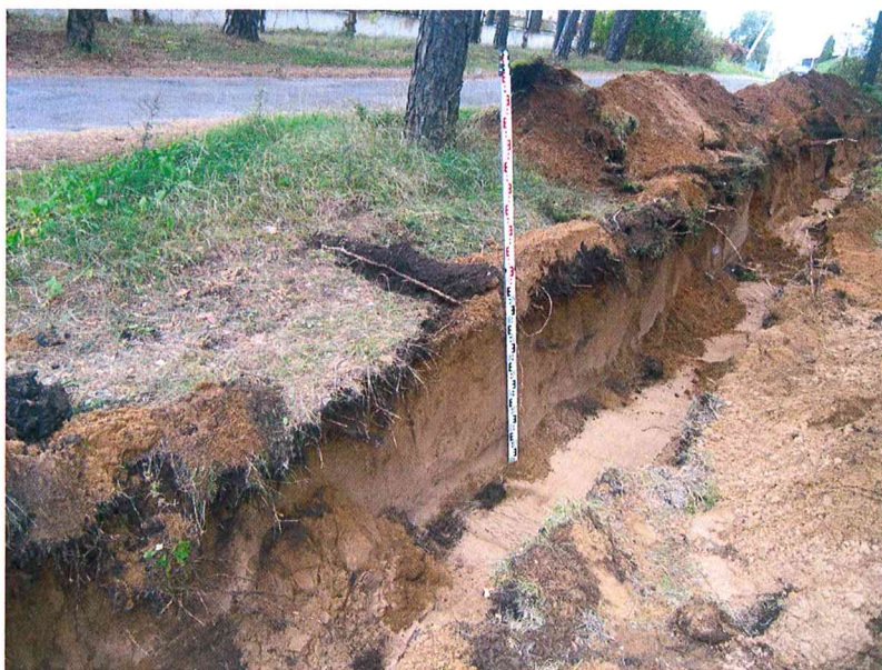
10 nuotr. Tranšėjos Nr. 3 vietoje iškastas griovys iš P pusės.
