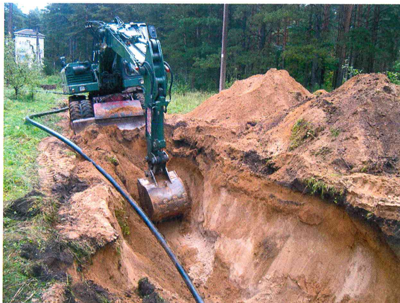
6 nuotr. Tranšėjos Nr. 1 atkarpa B pasiekus projektinį gylį iš PV pusės.
