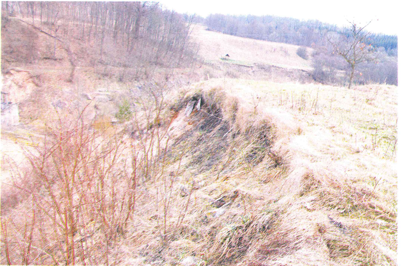
F.3 Bradeliškių piliakalnis. Šlaitų ir aikštelės dalies erozija piliakalnio V dalyje. Vaizdas iš PV
