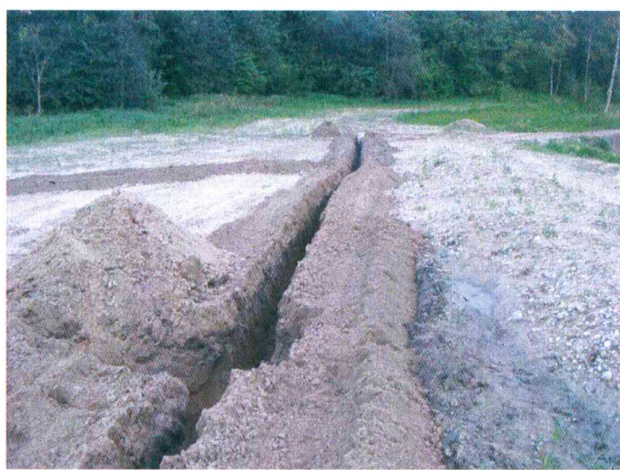
Pav. 36 Mechanizuotai nuimtas grunto sluoksnis kabelių vietoje R senovės gyvenvietės dalyje
