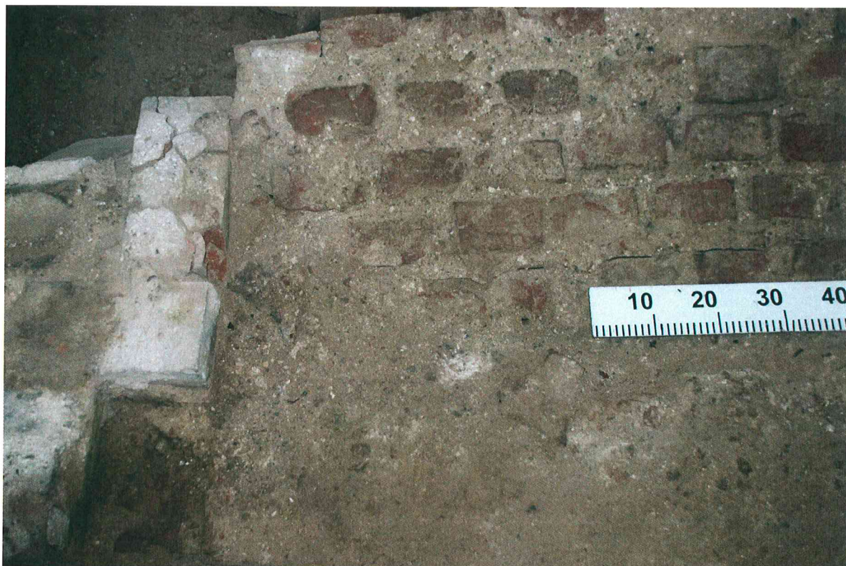
Pav. 2 Rūsio Nr. 2 skliautai iki sutvirtinimo, matomi įtrūkimai, vaizdas iš V pusės.
