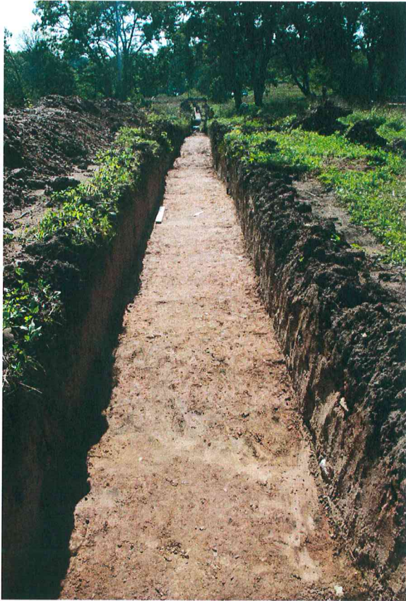
Pav. 43 Perkasa Nr. 2, kv. 50-60, vaizdas iš Š pusės.
