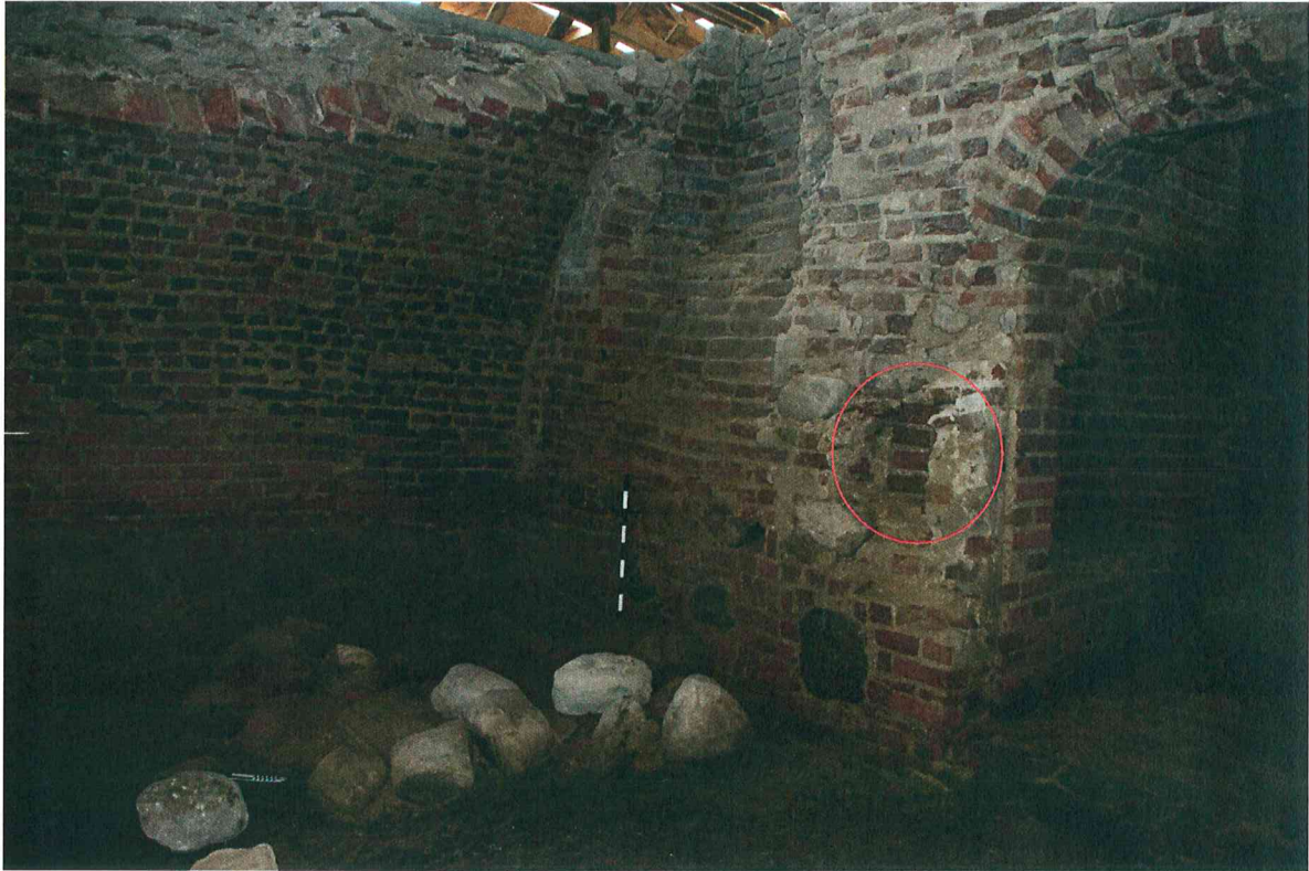
Pav. 7 Rūsysis Nr. 2, Š sienoje, tarp švieslangio ir laiptinės išmūryta namelio formos niša (apibraukta raudonai).
