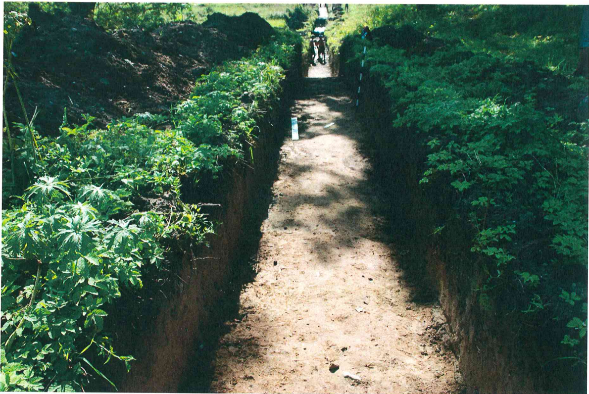
Pav. 48 Perkasa Nr. 2, kv. 80-90, vaizdas iš Š pusės.
