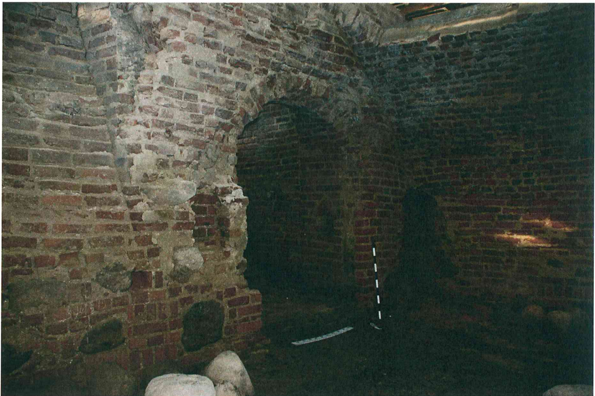
Pav. 8 Rūsysis Nr. 2, laiptinės arkinis praėjimas, vaizdas iš PV pusės.
