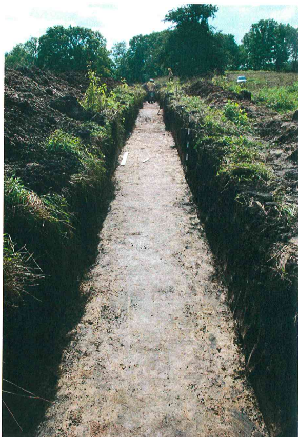
Pav. 56 Perkasa Nr.2, kv. 140-150, vaizdas iš Š pusės.
