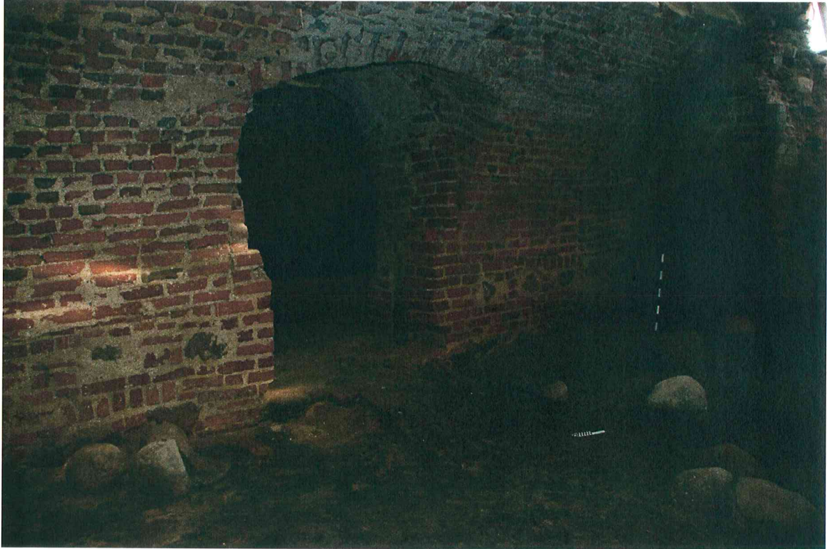
Pav. 9 Rūsīs Nr. 2, praējimas tarp rūsio Nr.1 ir rūsio Nr. 2, praėjime matoma durų staktos vieta, vaizdas iš ŠR pusės.
