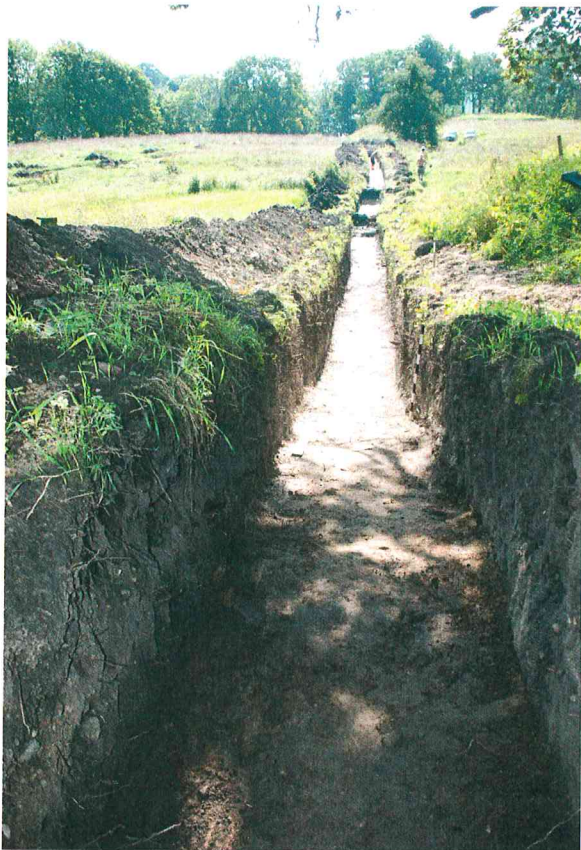
Pav. 50 Perkasa Nr. 2, kv. 90-110, vaizdas iš Š pusės.
