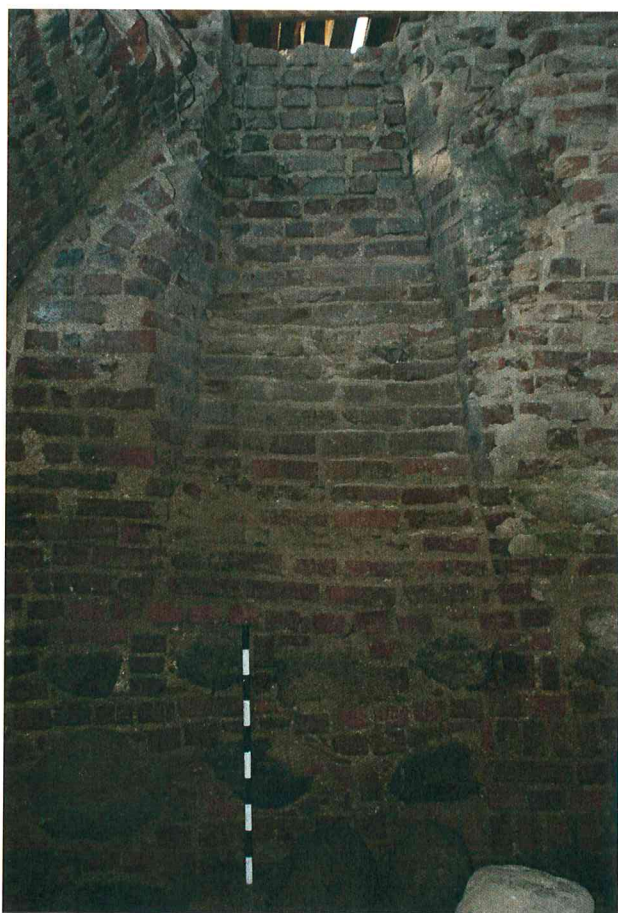
Pav. 6 Š rūšio Nr. 2 sienoje, V kampe aptiktas buvęs švieslangis, vaizdas iš P pusės.
