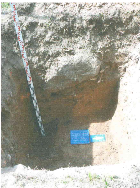
Šurfas Nr. 16, V sienelė (fotografuota iš R pusės)
