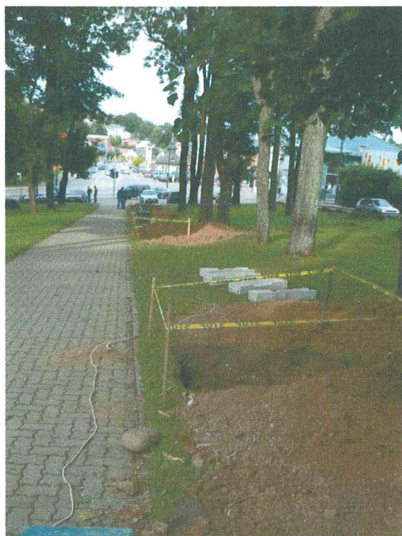
Šurfų Nr. 16-20 vieta (fotografuota iš R pusės)
